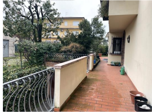
- Veduta generale fabbricato
