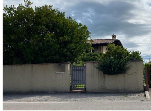
- Veduta generale esterna fabbricato
