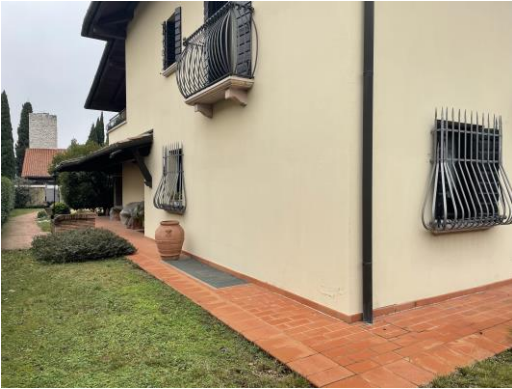
- Veduta generale fabbricato
