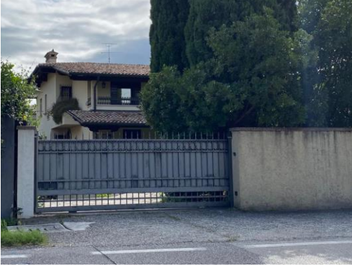
- Veduta generale esterna fabbricato
