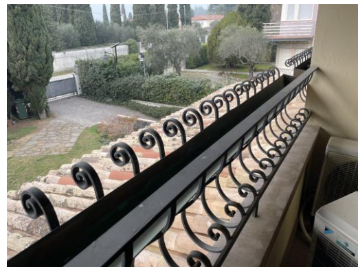
P1 – Vista esterna da terrazzo
