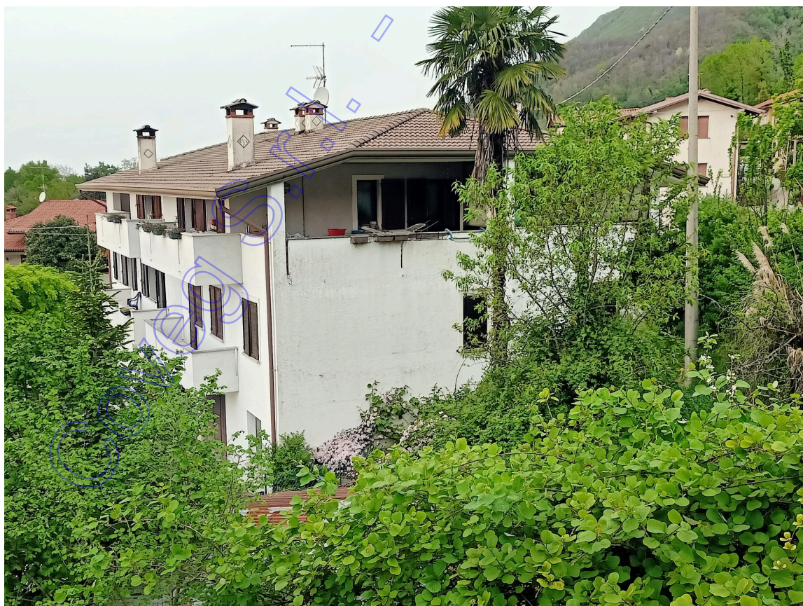
Vista Sud – Est dell'edificio condominiale
