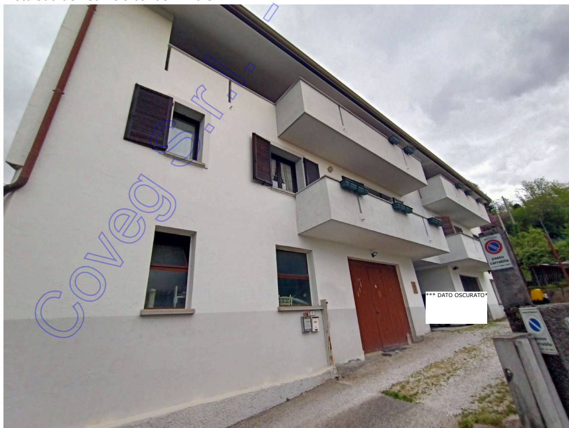
Vista Sud dell'edificio condominiale
