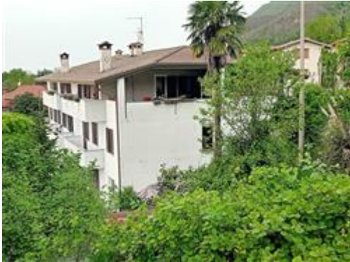
Vista Sud - Est edificio condominiale
