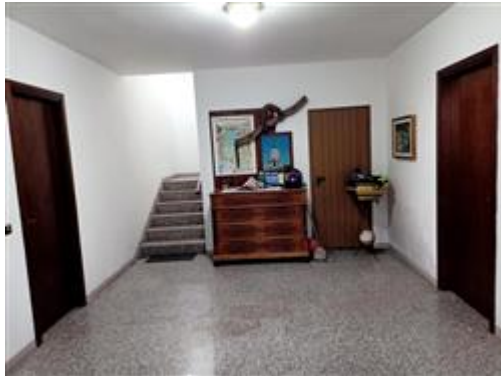
Dettaglio ingresso condominiale a piano terra
