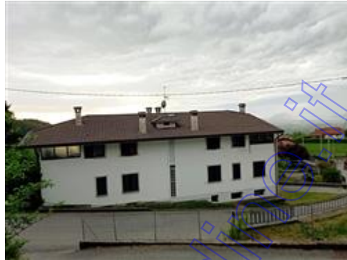
Vista Nord edificio condominiale
