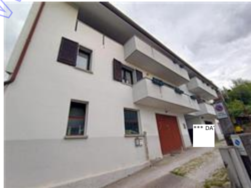
Vista Sud edificio condominiale
