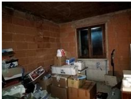
Dettaglio camera Sud
