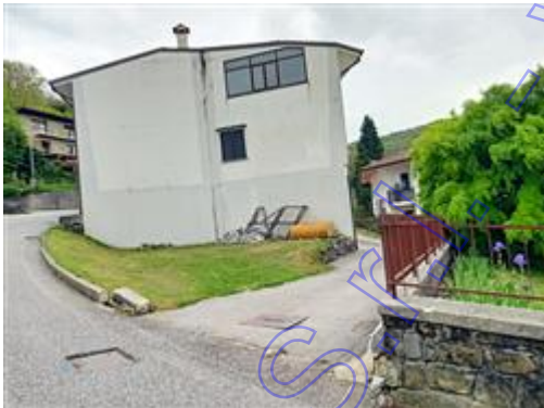
Vista Ovest edificio condominiale con viabilità di accesso
