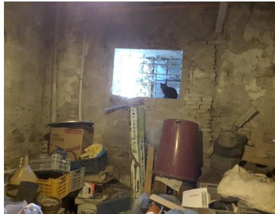
Le pareti risultano essere usurate con diversi segni di degrado, nello specifico, crepe, porzioni di intonaco staccato, parti parzialmente tinteggiate mentre il pavimento è in terra battuta con alcune aree in cemento.
