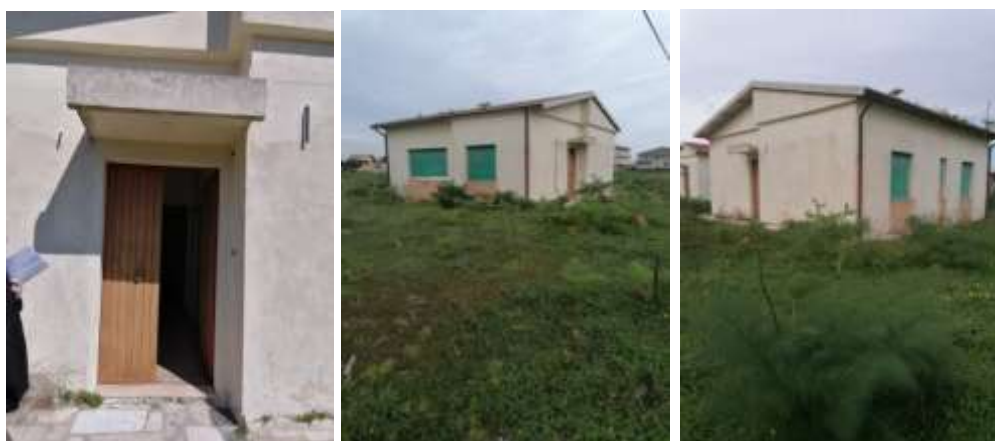
Locale a piano terra (ex ufficio amministrativo)
