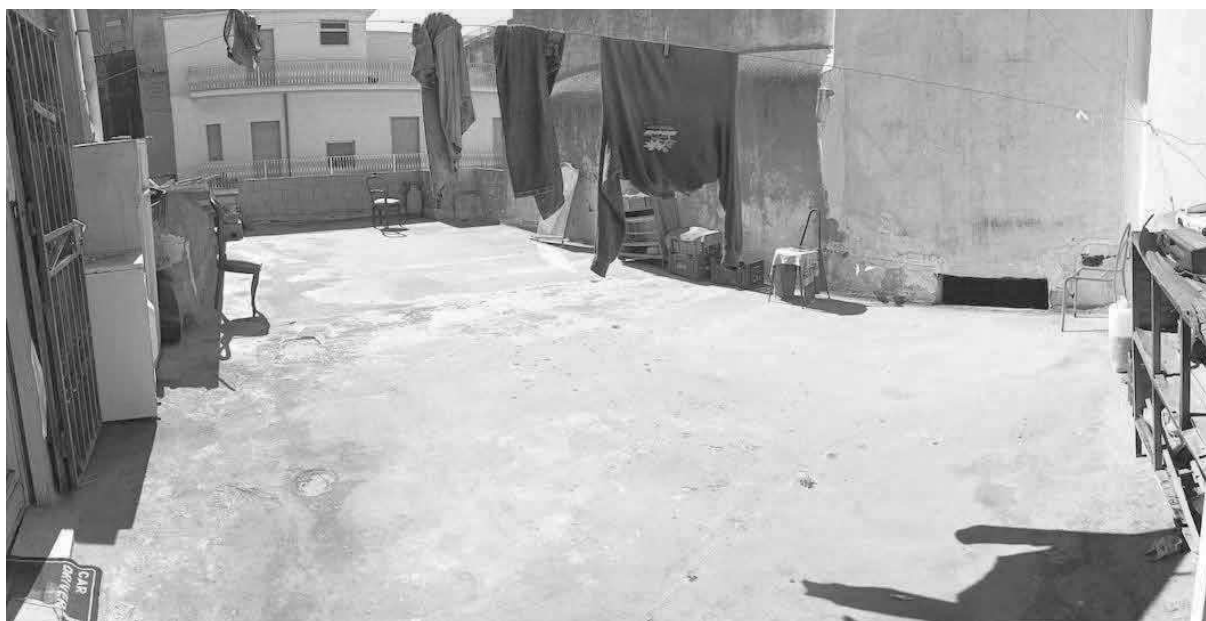
Foto 11 Lotto 2 – Lastrico solare appartamento piano primo
