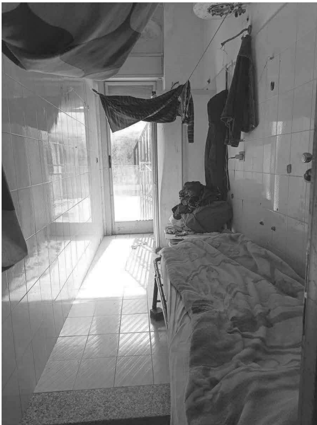
Foto 16 Lotto 2 – Ripostiglio appartamento piano primo
