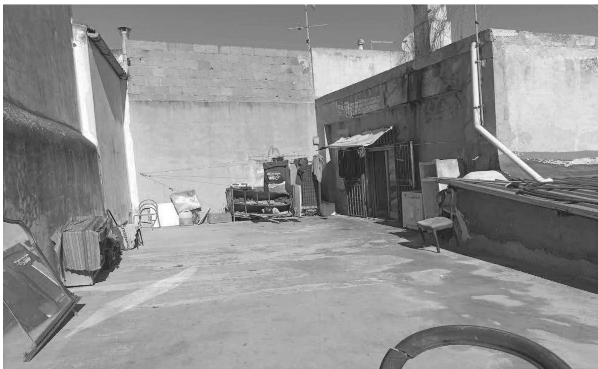
Foto 13 Lotto 2 – Lastrico solare appartamento piano primo
