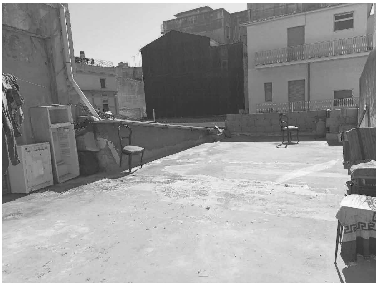
Foto 12 Lotto 2 – Lastrico solare appartamento piano primo
