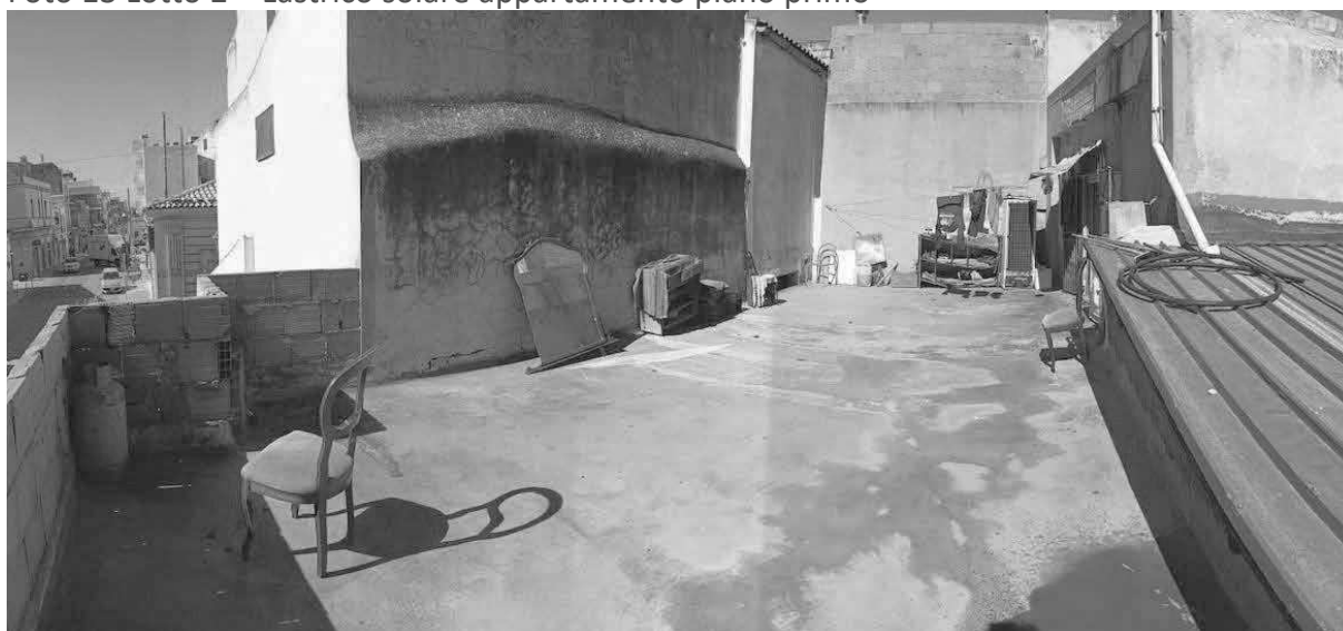
Foto 14 Lotto 2 – Lastrico solare appartamento piano primo
