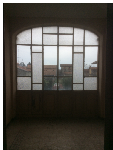
Locale verso corte interna
