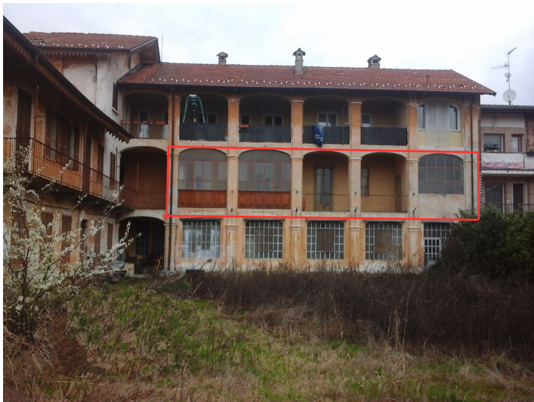
prospetto fabbricato principale
