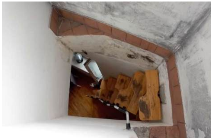
La porzione di solaio demolito in corrispondenza della scala
