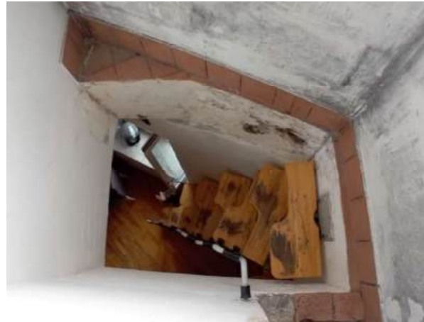
Lo smonto della scala, la porzione di solaio “bucata”
