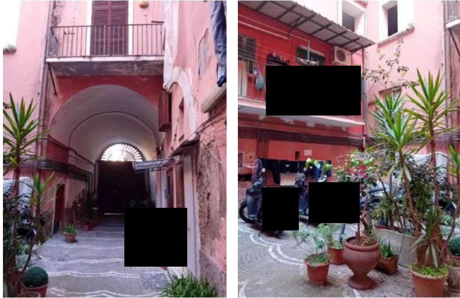
Fabbricato di via Sanità 55: portone d'ingresso e corte interna del fabbricato
