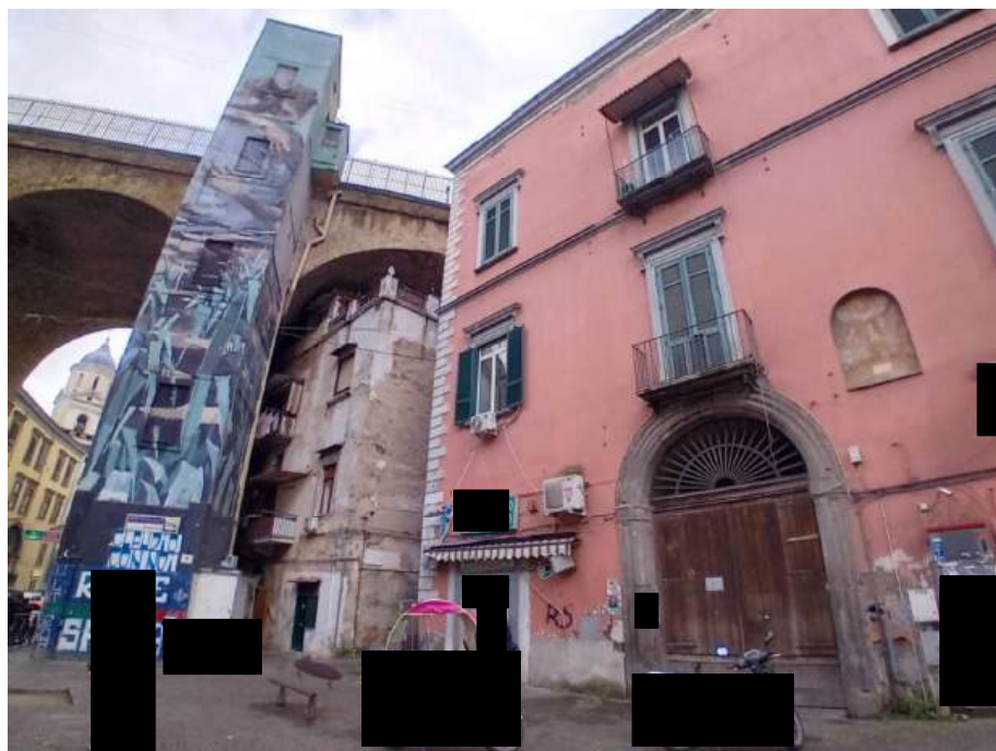
Fabbricato compreso di via Sanità 55: portone d'ingresso e, in secondo piano, l'ascensore della sanità
