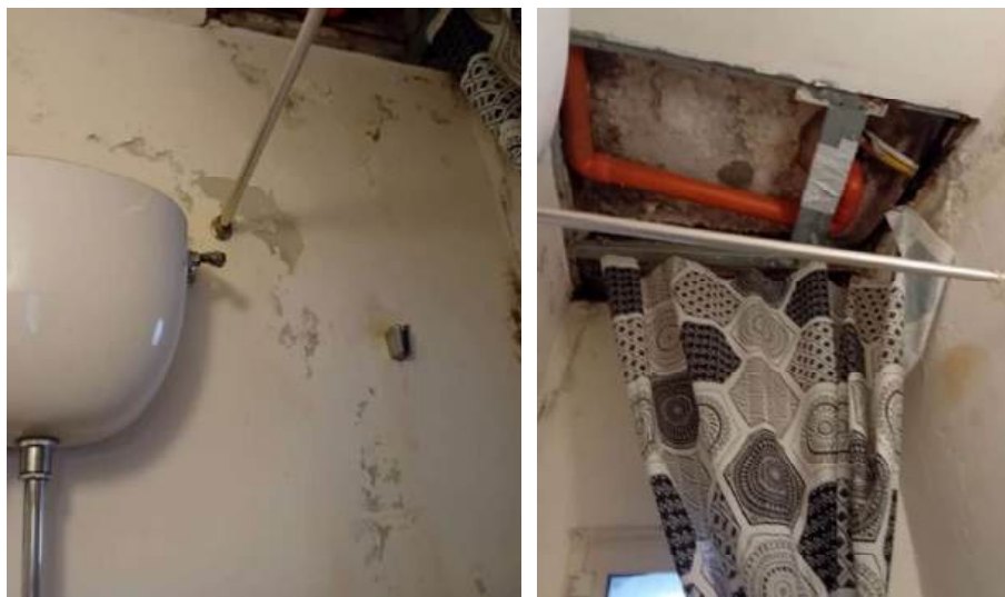
Dettagli dei recenti lavori di sistemazione nel controsoffitto del bagno
