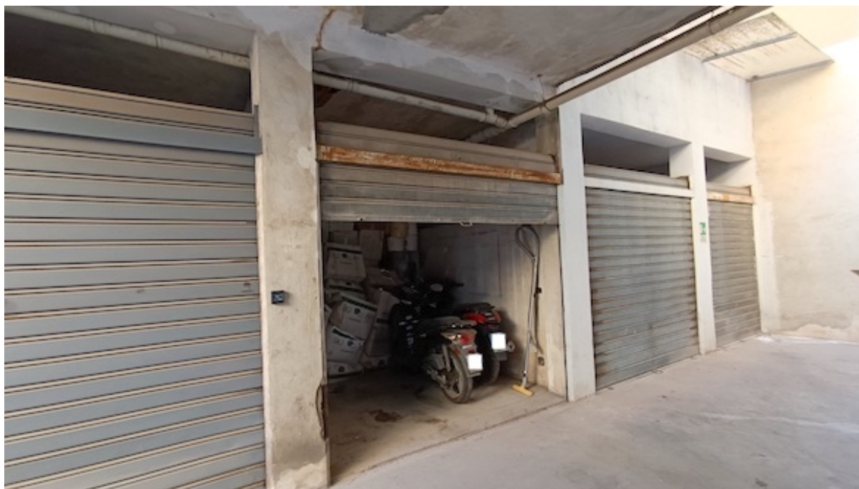
Foto 8 Lotto 1 – Accesso al garage sub 34 piano sotterraneo
