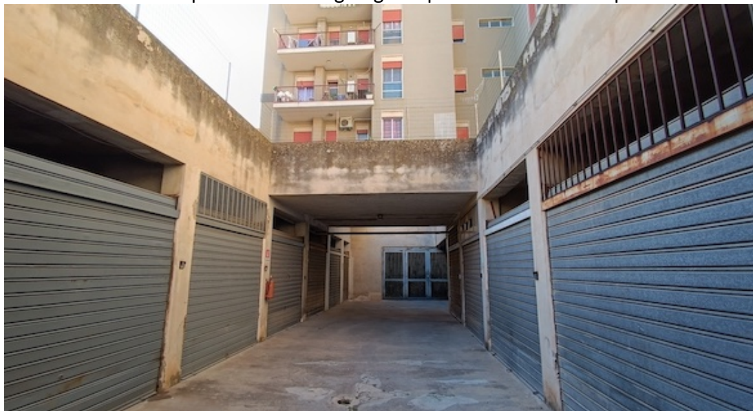
Foto 6 Lotto 1 – Corridoio per accesso ai garage piano sotterraneo
