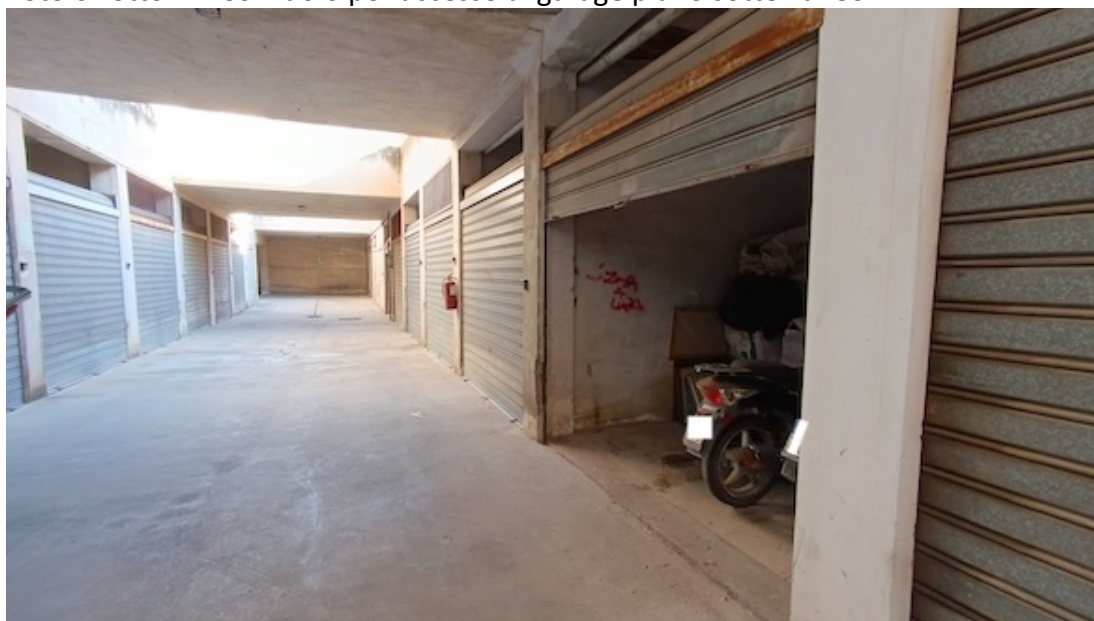
Foto 7 Lotto 1 – Accesso al garage sub 34 piano sotterraneo
