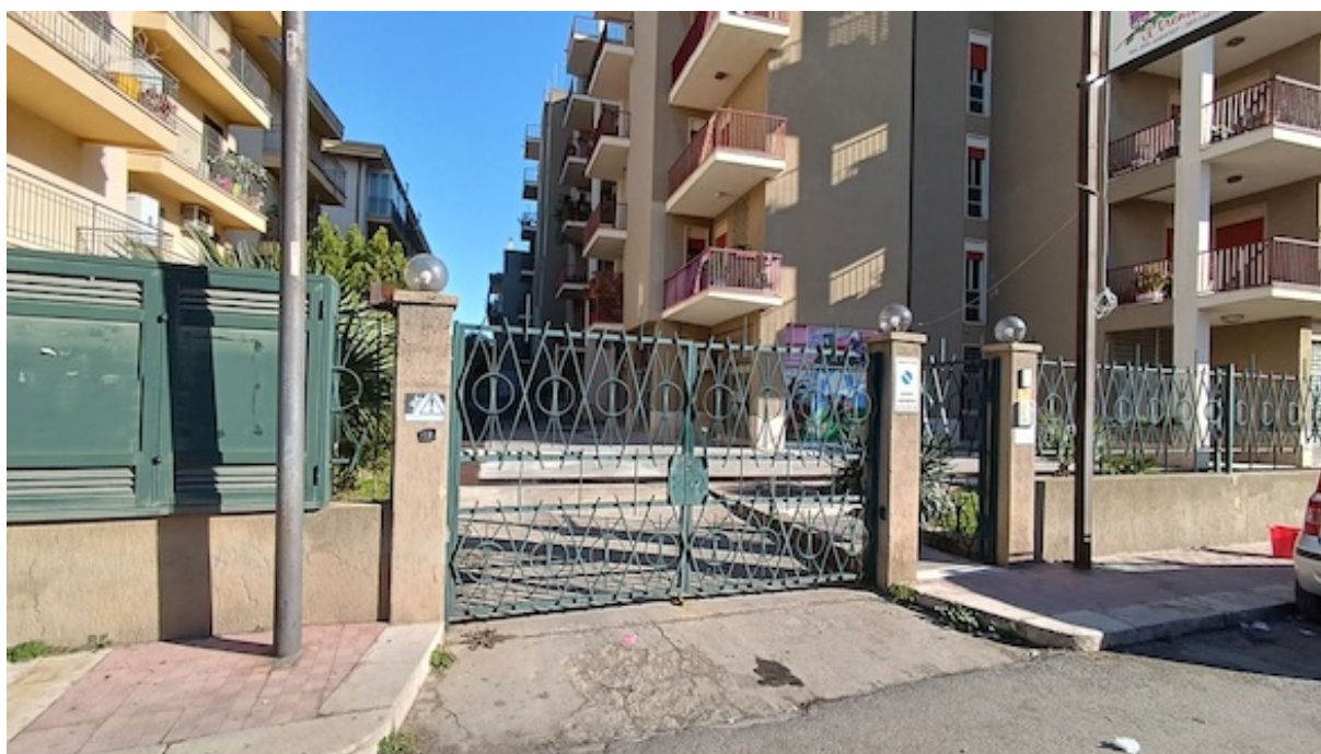
Foto 2 Lotto 1 – Accesso carrabile ai garage ed accesso pedonale da Viale Generale Cascino
