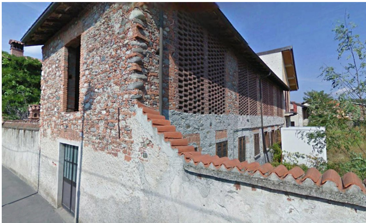
prospetto fabbricato principale
