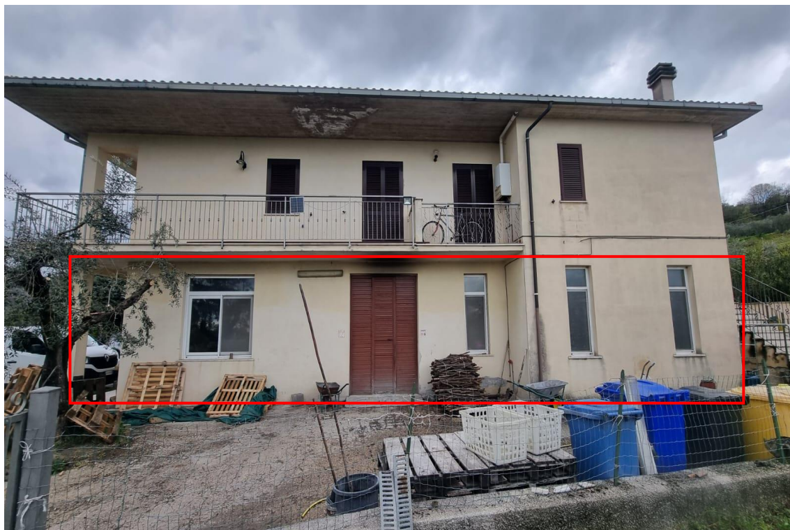
Foto n. 3 Esterno del Fabbricato Prospetto Sud-Ovest
