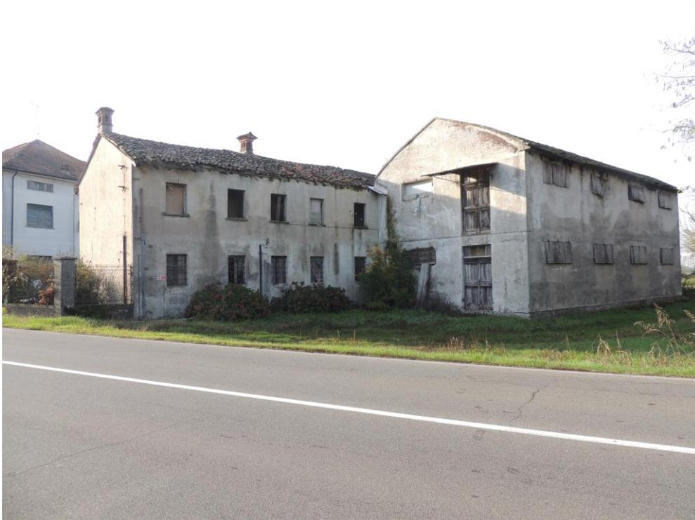
Edificio a produttivo composto da più corpi di fabbrica in aderenza e portico fronte corte interna. Porzione di fabbrica su due livelli ex abitazione per questioni di sicurezza non è stato visionato l'interno, si riscontrano fessurazioni strutturali sulle murature portanti, edificio in pessimo stato. Altro corpo di fabbrica a magazzino, su due livelli con copertura a volta. Portico ed essiccatore.
