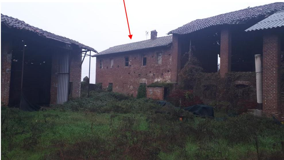
Altro corpo di fabbrica senza portico, copertura ristrutturata, su due livelli a magazzino. Fabbricato da ristrutturare, una porzione di solaio interno crollato. CONSISTENZA LORDA PIANO T-P1° MQ 234,00 circa
