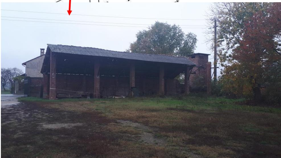
Portico a ridosso della sp.206 in scarso stato di manutenzione con porzione di falda, lato corte interna, avente lastre di eternit da bonificare.
