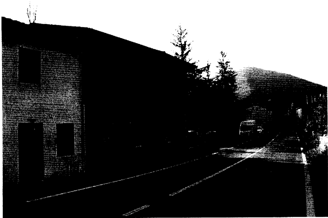
FOTO N° 2 Vista esterna del complesso edilizio
