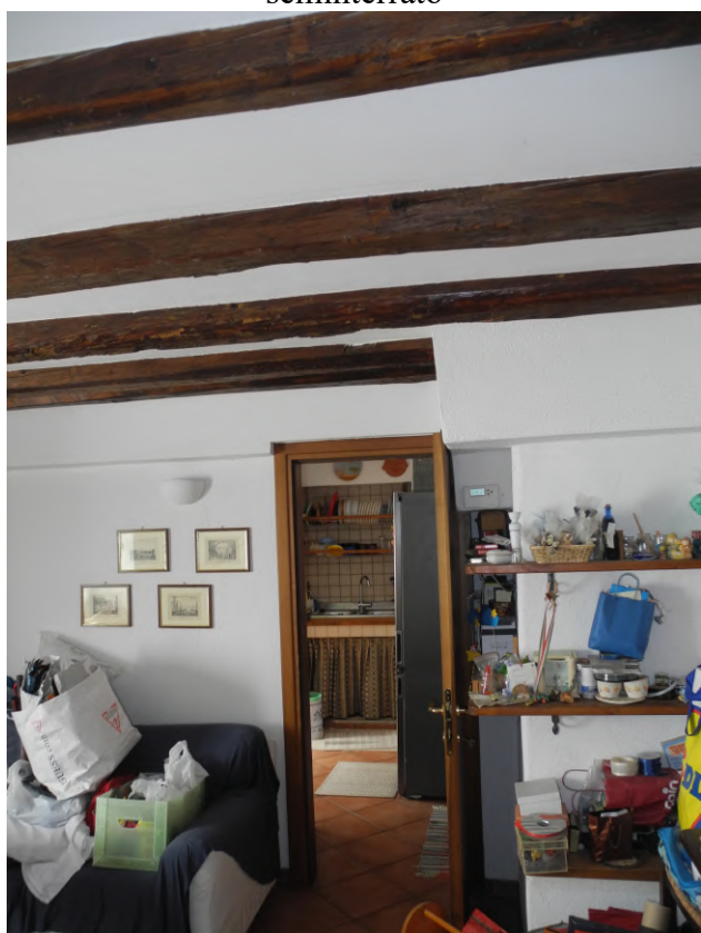
FOTO 32 – vano cantina (soggiorno/taverna) al seminterrato
