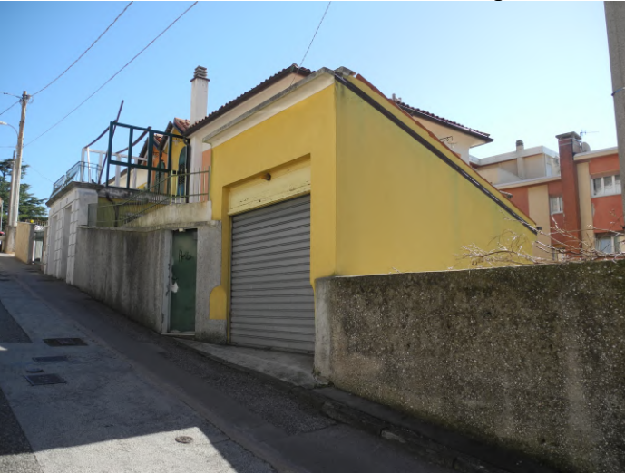
FOTO 2 – vista dalla strada – box auto su p.c.n. 1518
