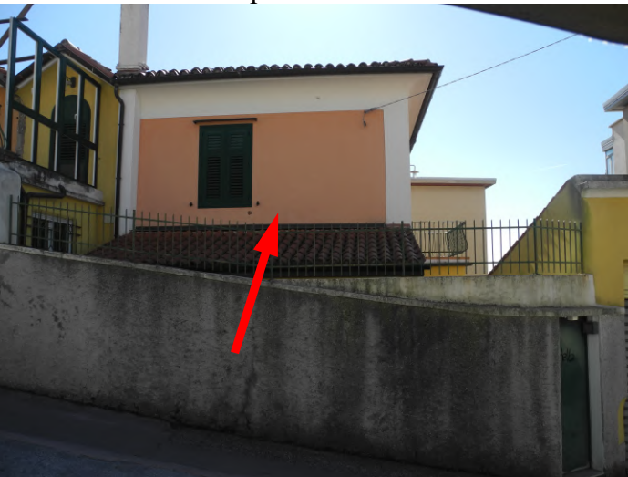
FOTO 3 – porzione immobile non condominiale, su p.c.n. 1518
