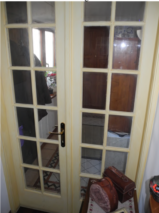
FOTO 40 – atrio ingresso da portocino accessibile da via Romagna 39
