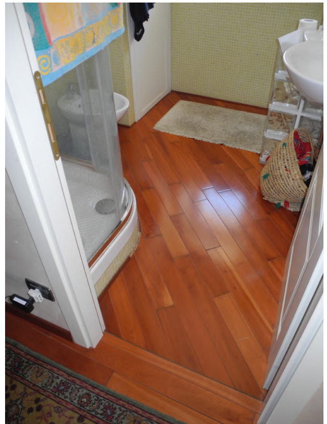
FOTO 50 – bagno-w.c. zona notte – parte condominiale
