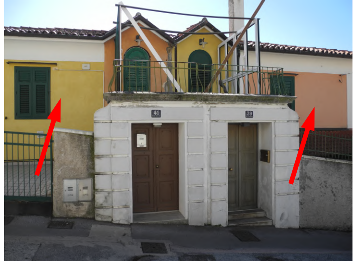
FOTO 5 – immobile civv. 39-41 visto dalla strada
