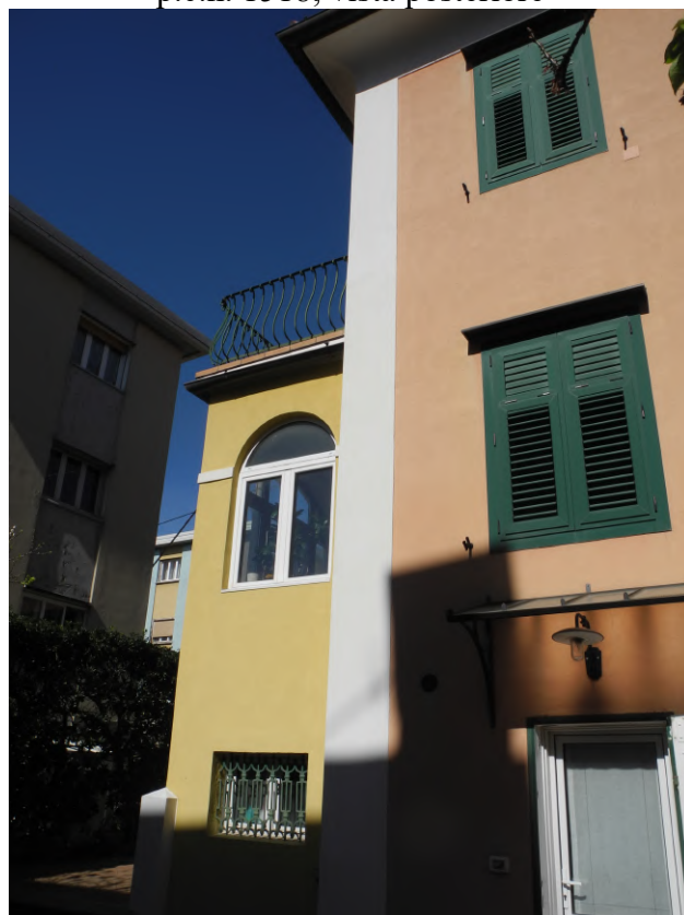
FOTO 16 – porzione immobile non condominiale, su p.c.n. 1518; vista posteriore
