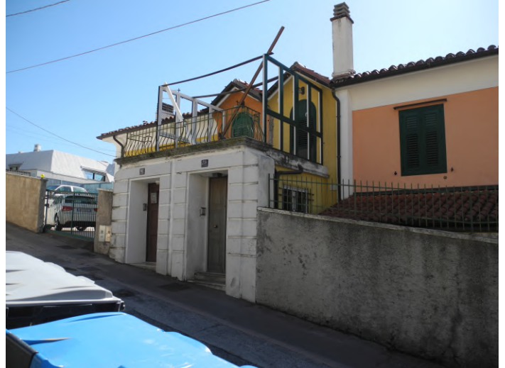
FOTO 4 – immobile civv. 39-41 visto dalla strada
