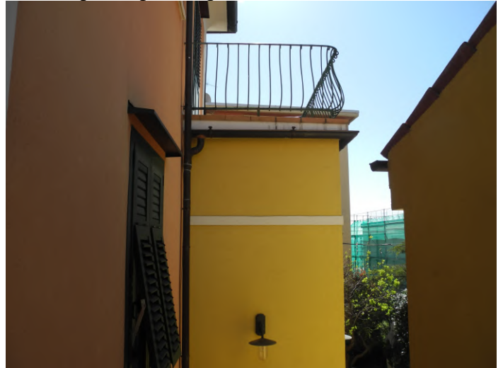
FOTO 45 – terrazzo accessibile dalla camera da letto primo piano– parte non condominiale
