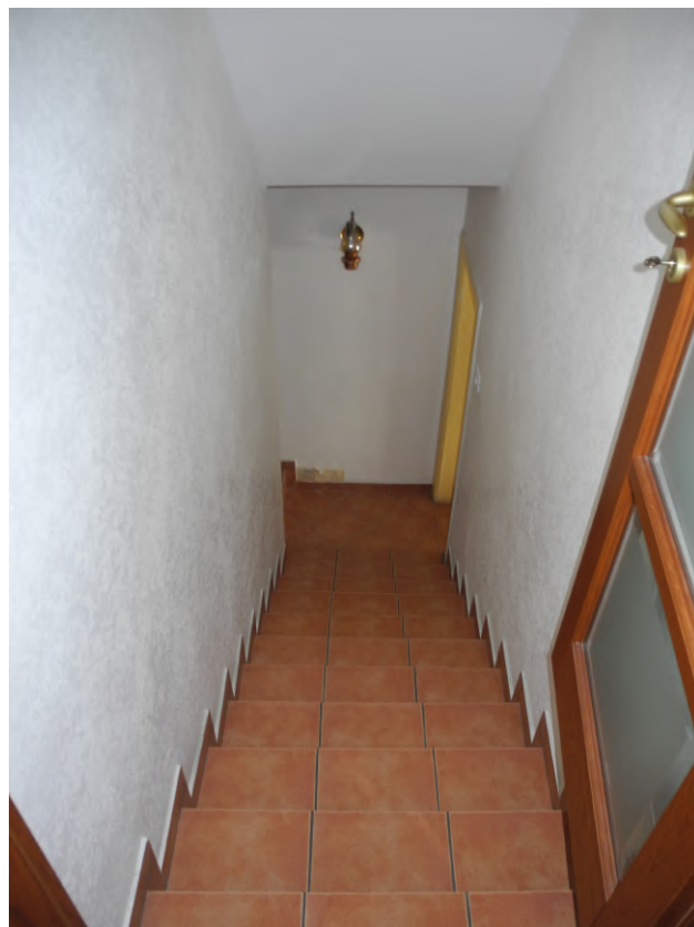
FOTO 30 – scala di discesa verso piano cantina seminterrata
