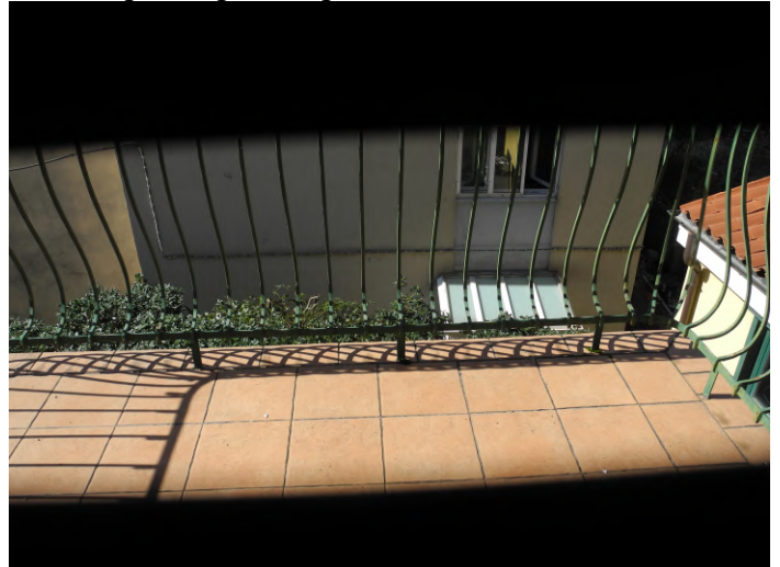
FOTO 46 – terrazzo accessibile dalla camera da letto primo piano– parte non condominiale
