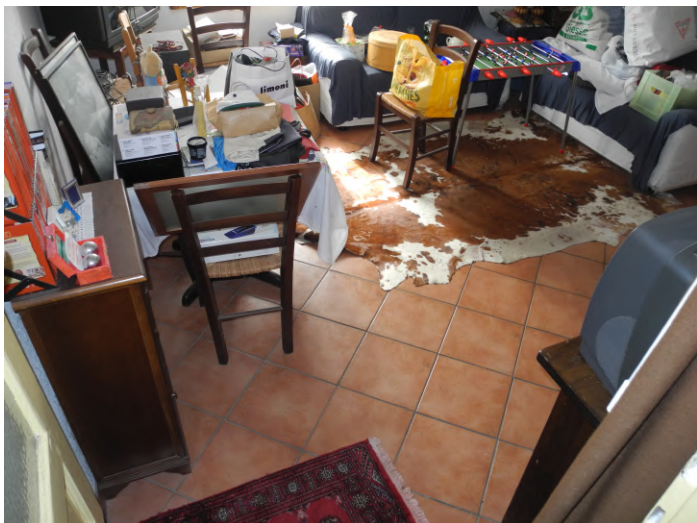
FOTO 31 – vano cantina (soggiorno/taverna) al seminterrato
