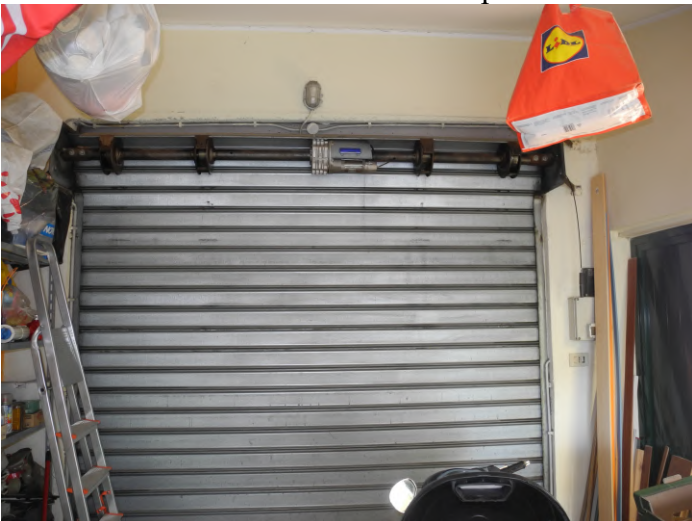
FOTO 10 – interno box auto su p.c.n. 1518
