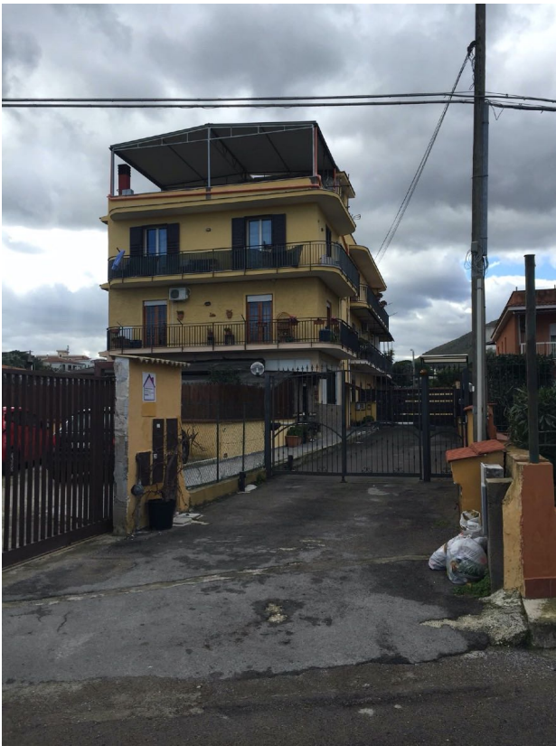
FOTO N. 1 - Vista dell'edificio da via Eleuterio
