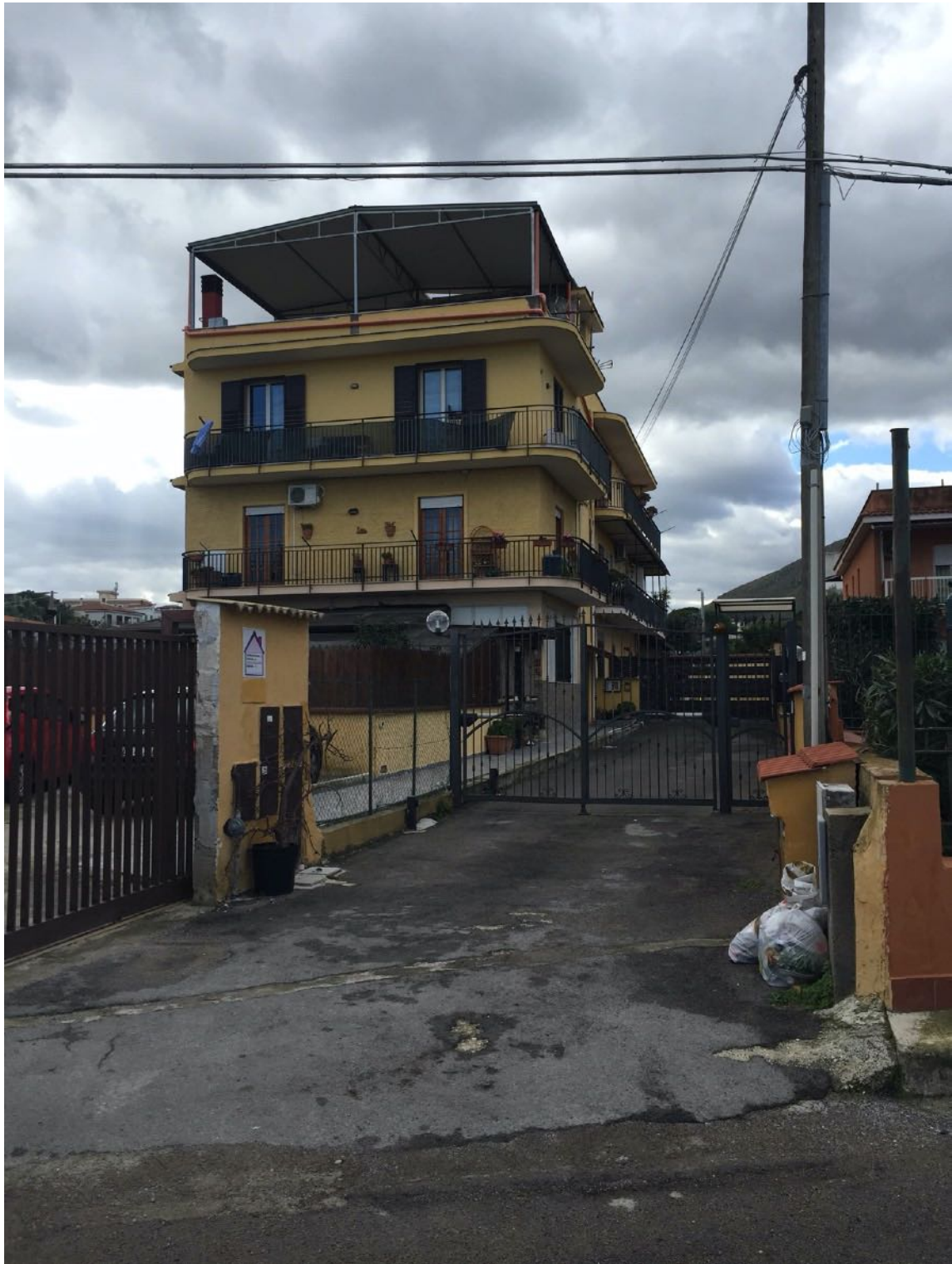
FOTO N. 1 - Vista dell'edificio da via Eleuterio
