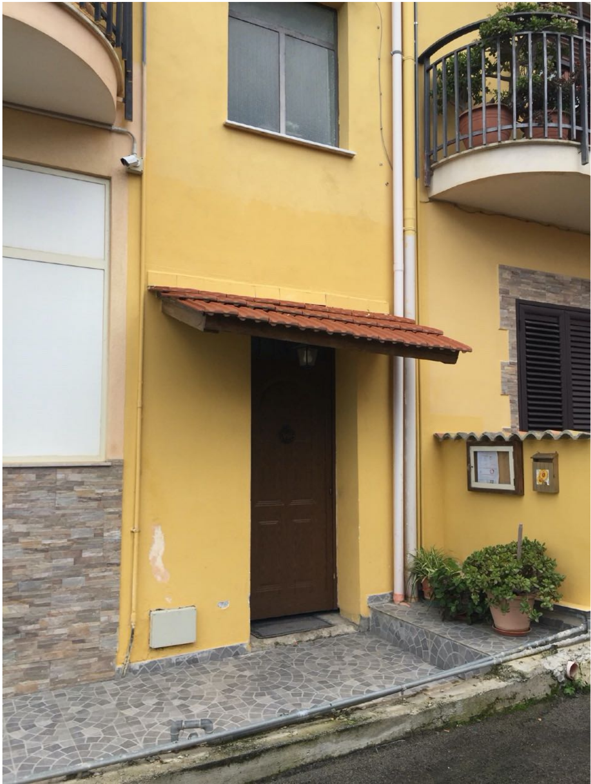
FOTO N. 3 - Ingresso al vano scala condominiale
