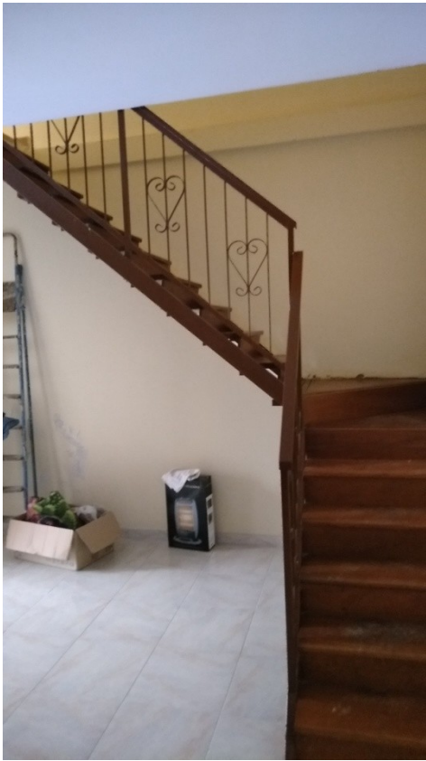
Scala interna di collegamento tra il piano primo ed il secondo.
