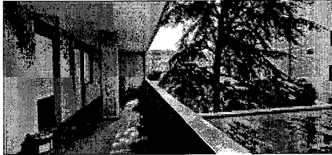
terrazzo al piano primo
