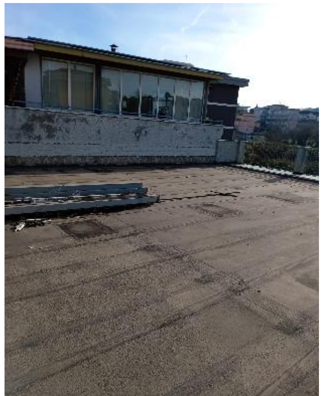
Viste esterne del lastrico solare
