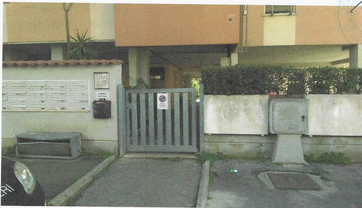
Foto n.2) Accesso pedonale all'edificio nel quale ricadono le unità immobiliari oggetto di accertamento in Anzio -loc.tà Lavinio- in Via dei Pesci n. 5 – edificio "C3" scala "A".
