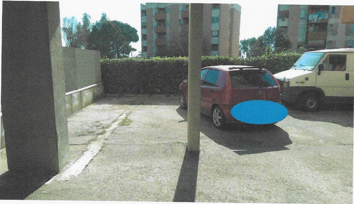
Foto n.3) Posti auto al piano terra Anzio -loc.tà Lavinio- in Via dei Pesci n. 3 / 5 – edificio “C3” scala “A”.
