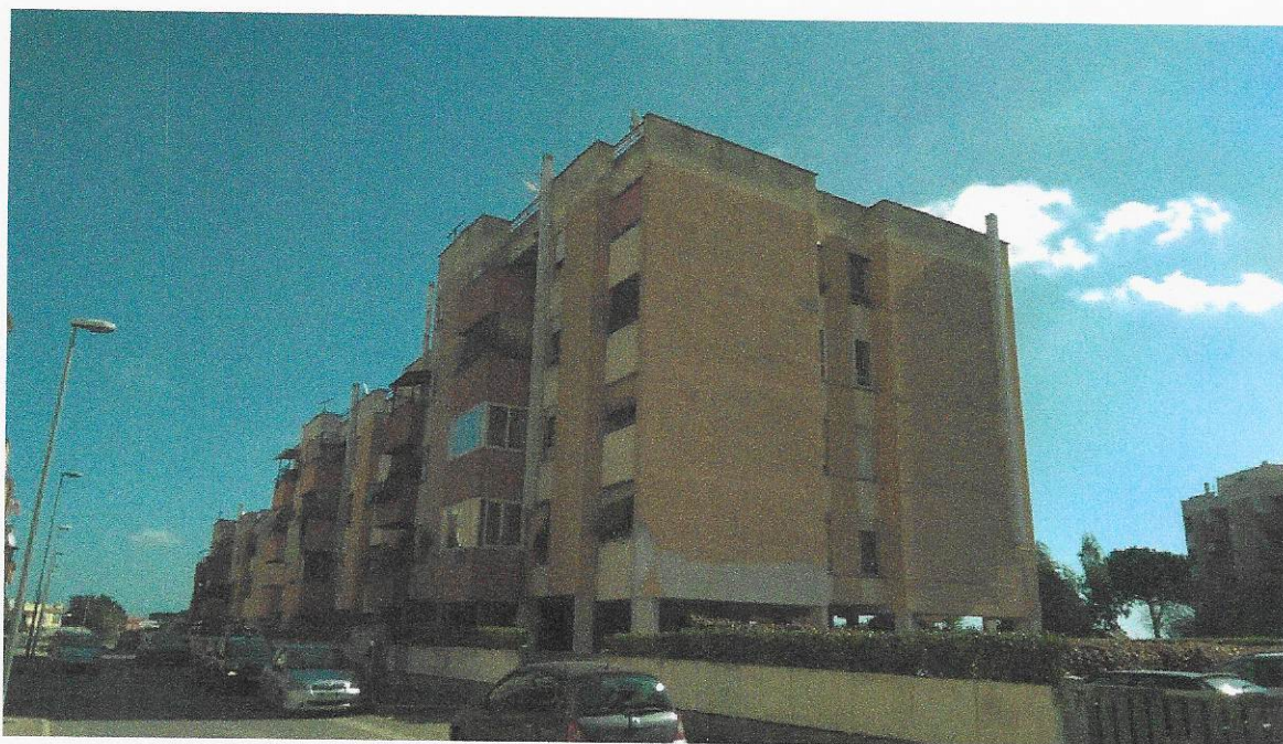
Foto n.1) Edificio nel quale ricadono le unità immobiliari oggetto di accertamento in Anzio -loc.tà Lavinio- in Via dei Pesci.
