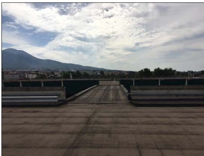
Corridoio pensile di collegamento tra sub 77 e sub 78
