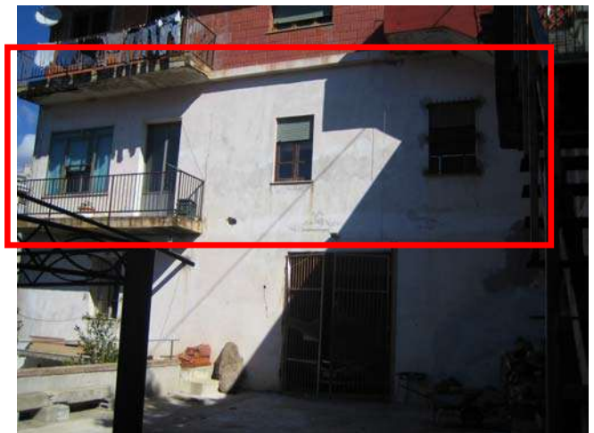
Foto 4 Fabbricato vista laterale piano terra
