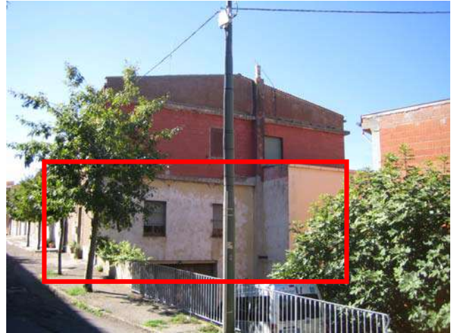
Foto 2 fabbricato vista laterale piano terra
