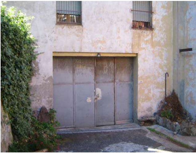
Foto 1 Ingresso primo piano seminterrato
