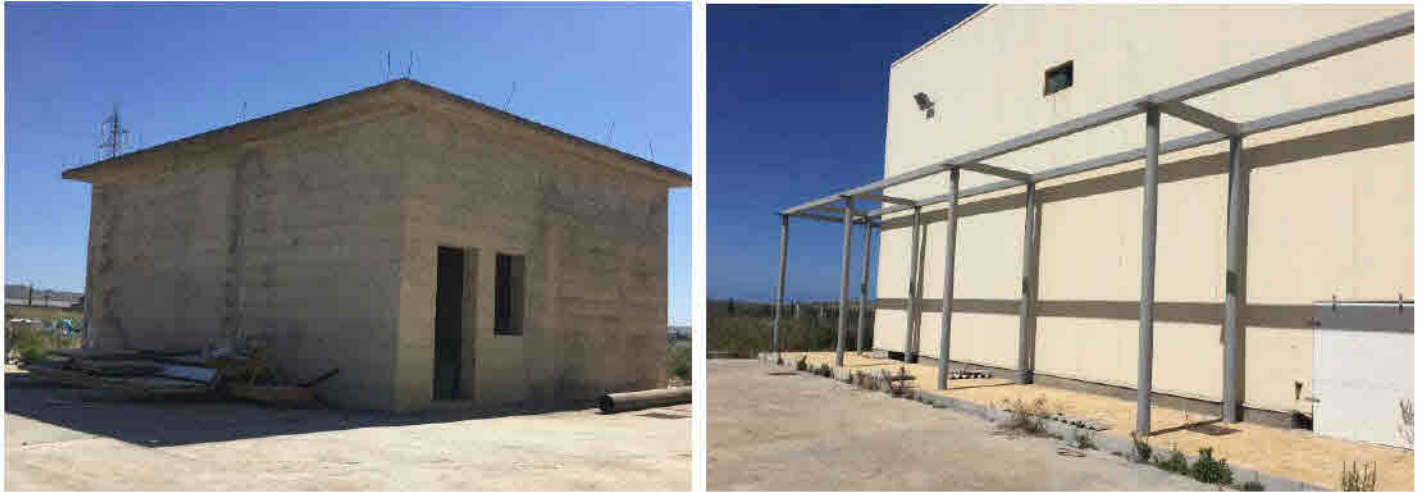
Foto 10 e 11 - Locale riserva idrica posto a nord e tettoia non completata posta in corrispondenza del vertice sud-est
