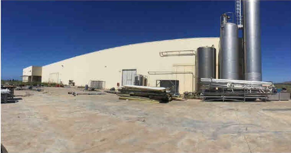
Foto 6- Prospetto nord-est con i silos per lo stoccaggio e dosaggio di zucchero, farina glucosio ed altro
