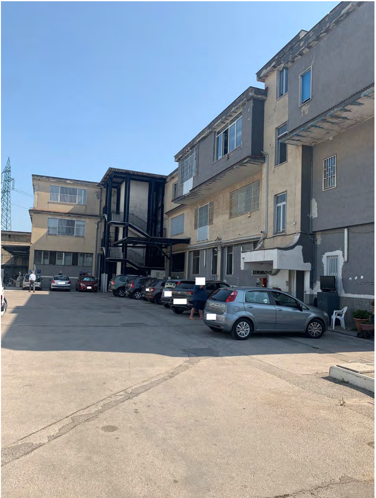
Foto dell'edificio da viale Siracusa
