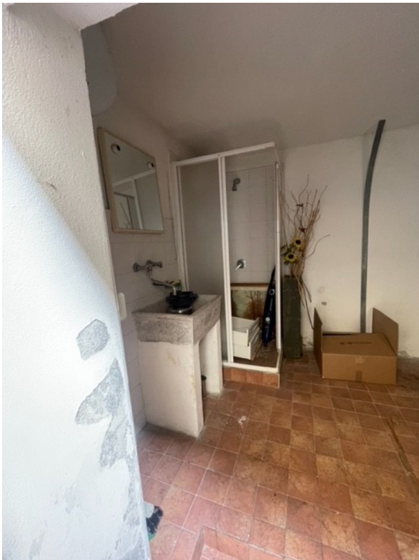
Figura 7. Ripostiglio al Piano Terra.
