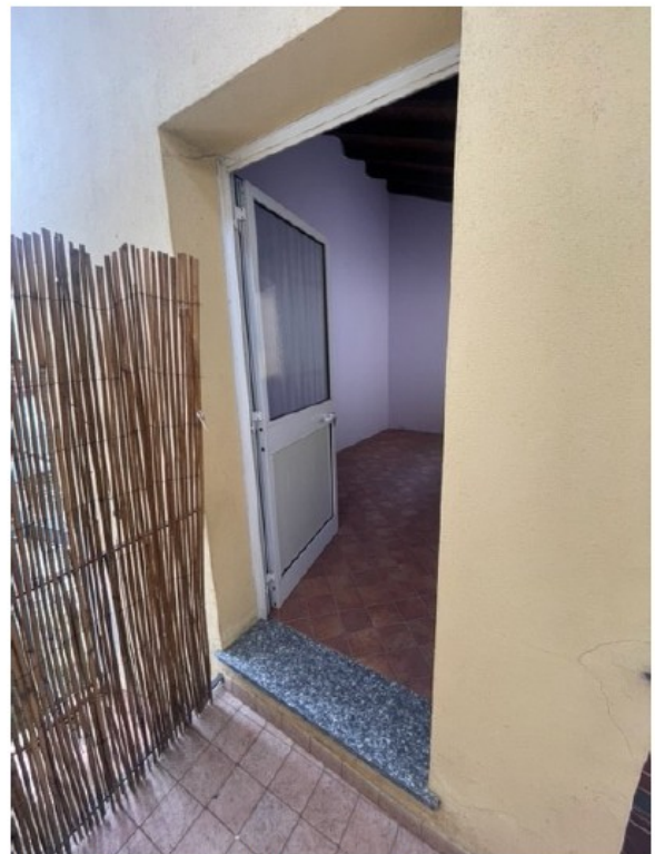
Figura 14. Ripostiglio al Piano Primo / Balcone.
