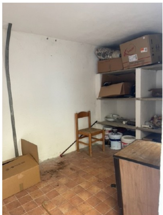
Figura 6. Ripostiglio al Piano Terra.
