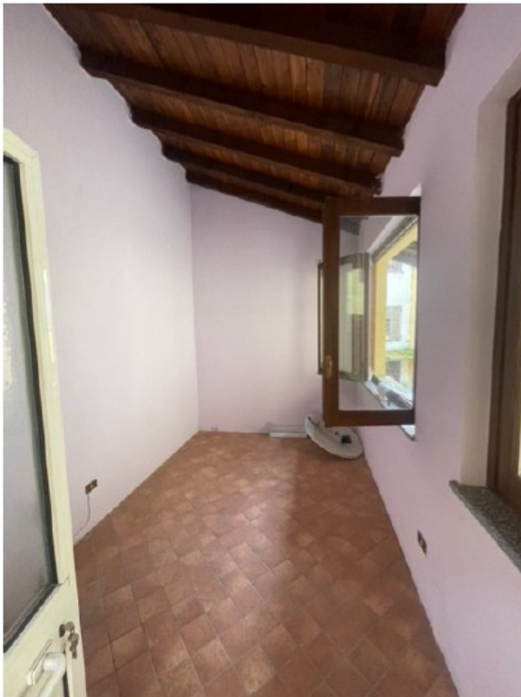
Figura 13. Ripostiglio al Piano Primo.
