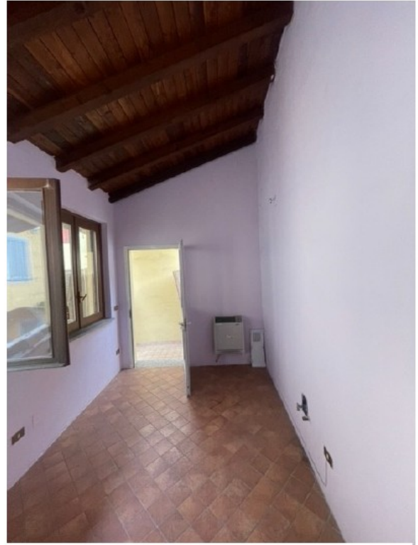
Figura 12. Ripostiglio al Piano Primo.
