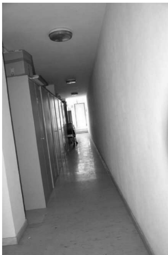
Corridoio su tre piani interno al sub 6
