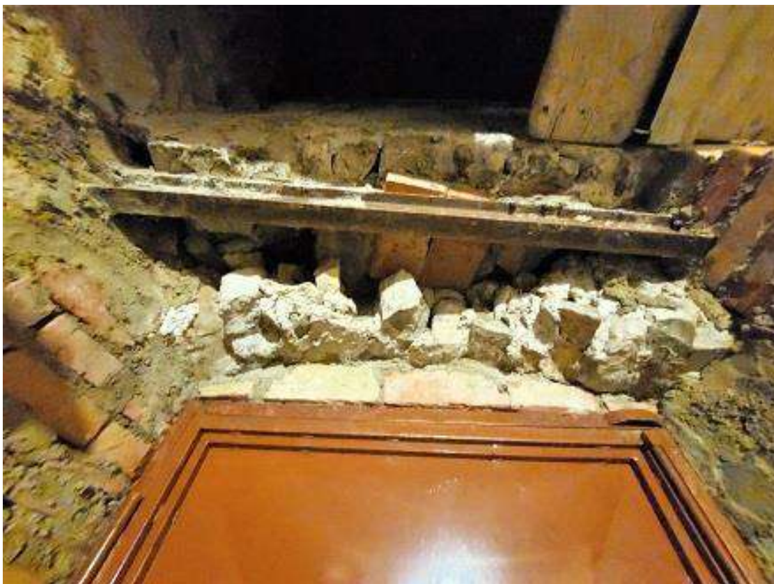
22 = Magazzino di P.T. – vano D (part. architrave)
