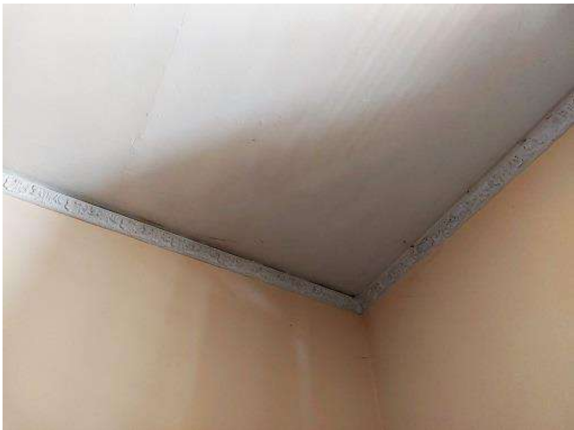
32 = Abitazione di 1°P – vano F (part. soffitto)
