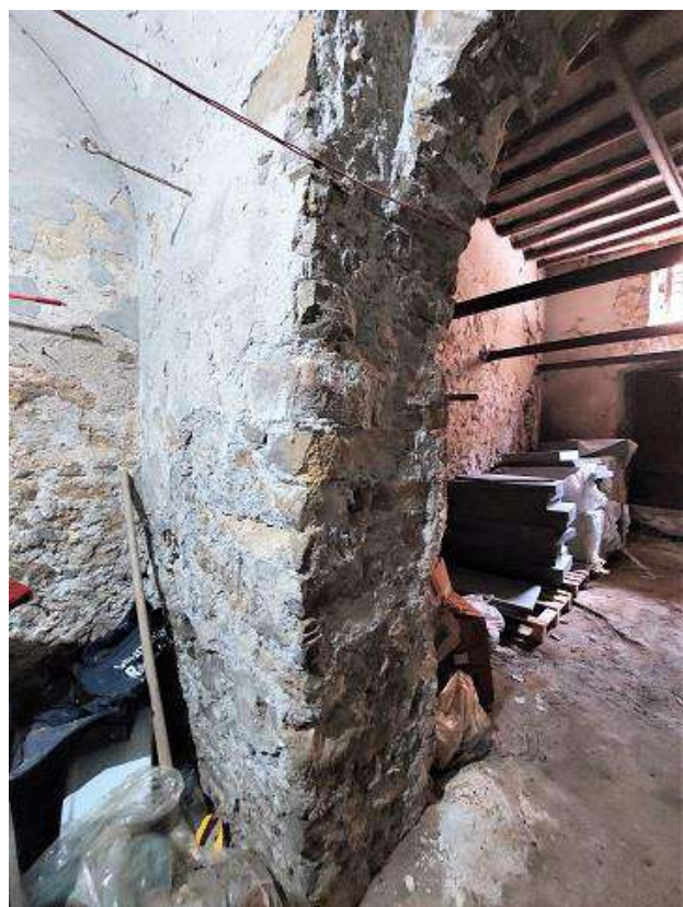
9 = Magazzino di P.T. – vano B (vista verso vano C)
