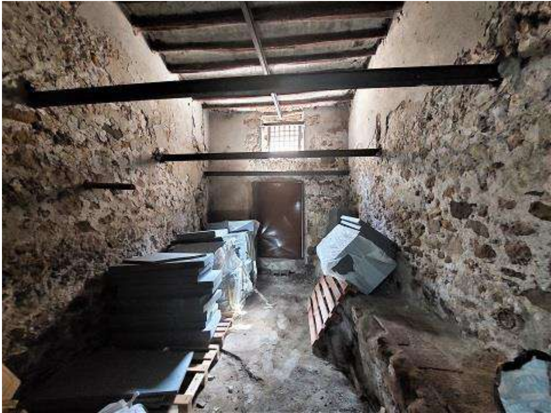
12 = Magazzino di P.T. – vano C (vista verso ingresso via Lucania)
