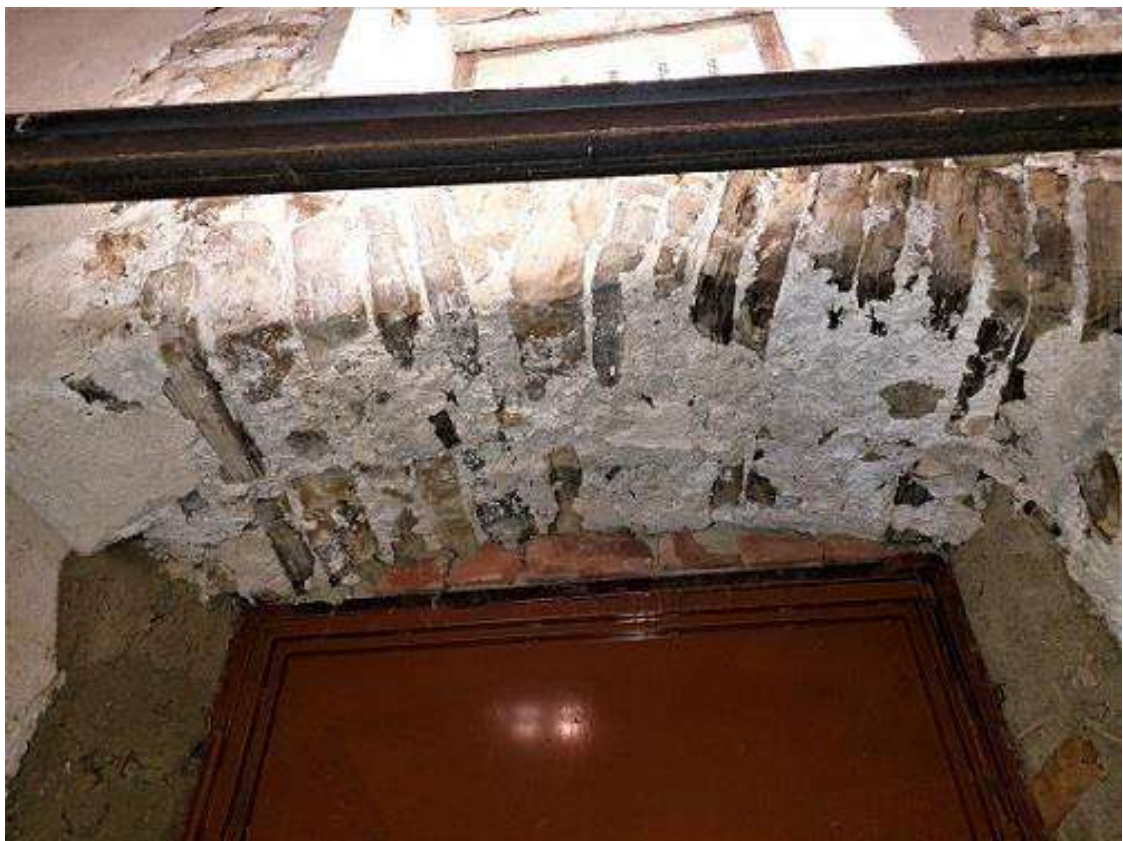
13 = Magazzino di P.T. – vano C (part. struttura architrave porta su via Lucania)
