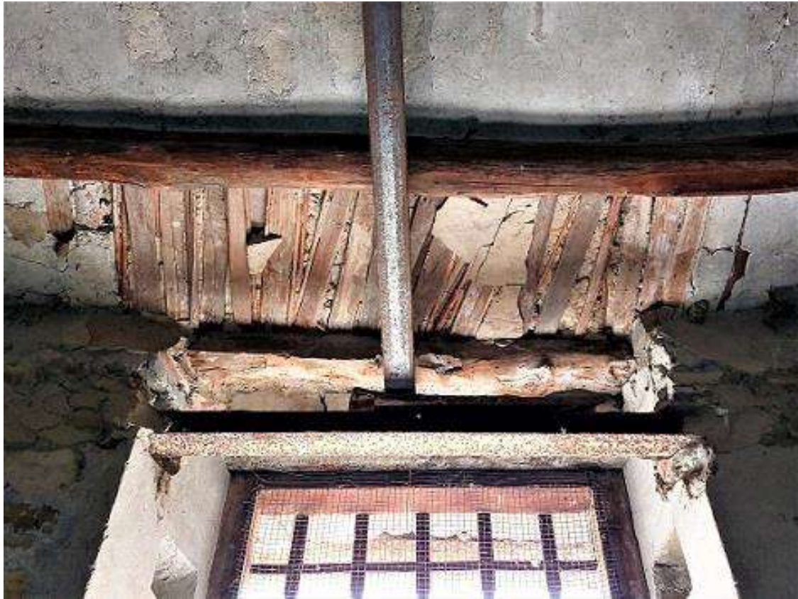
14 = Magazzino di P.T. – vano C (part. struttura architrave finestra su via Lucania)
