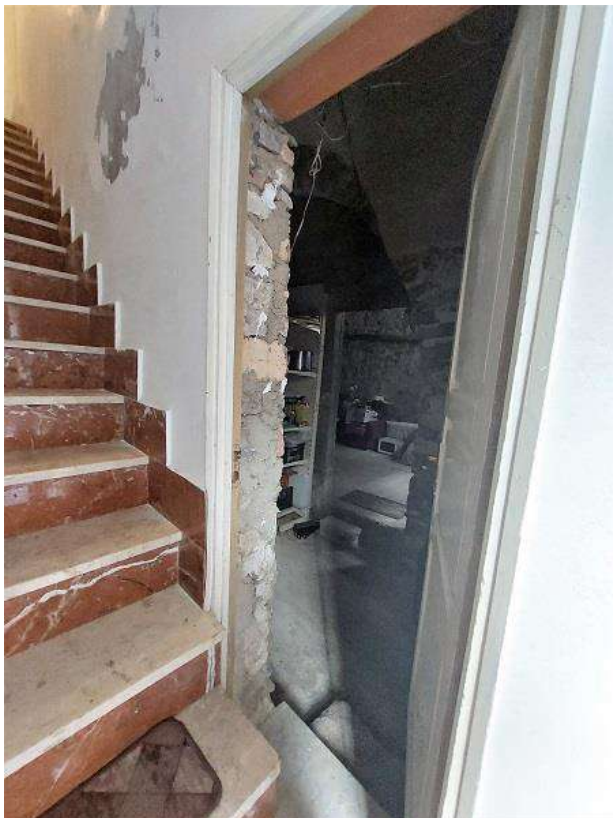
4 = Ingresso al magazzino di P.T.
