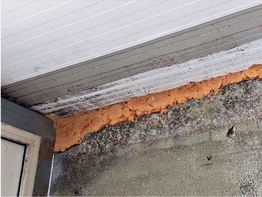
91 = Abitazione di 3°P – vano S (part. della copertura)
