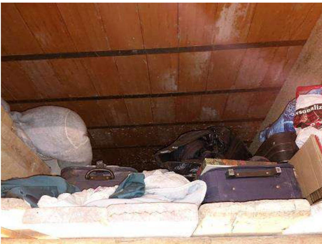
23 = Magazzino di P.T. – vano D (part. intradosso del solaio del primo piano)
