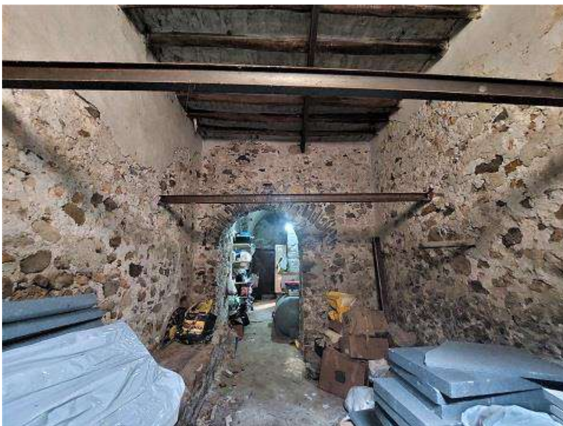
11 = Magazzino di P.T. – vano C (vista verso vano A)
