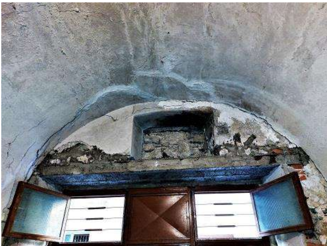
28 = Magazzino di P.T. – vano E (part. architrave)
