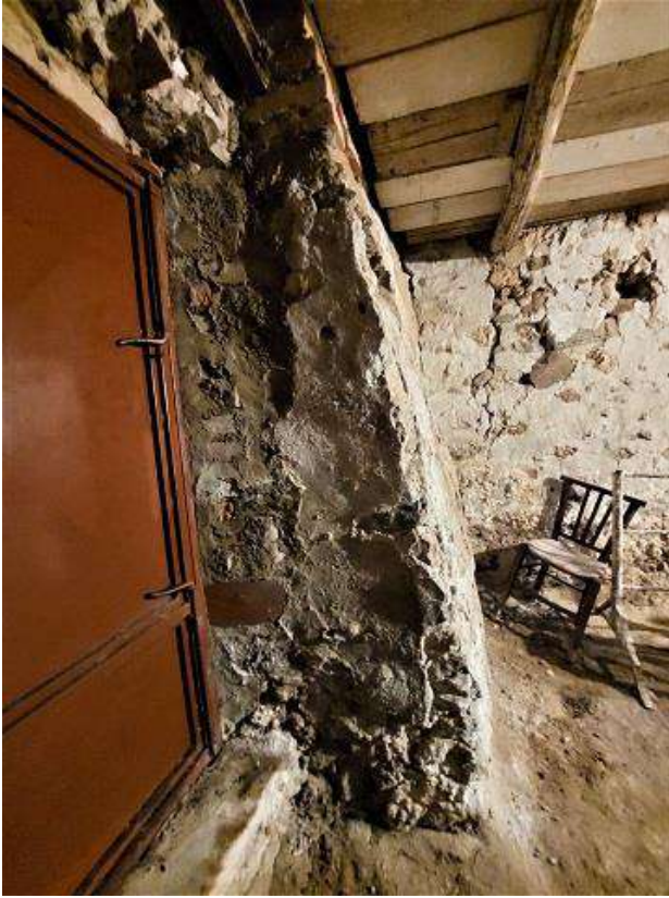
24 = Magazzino di P.T. – vano D (part. della muratura)
