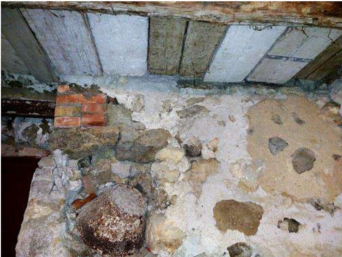
26 = Magazzino di P.T. – vano D (part. della muratura)
