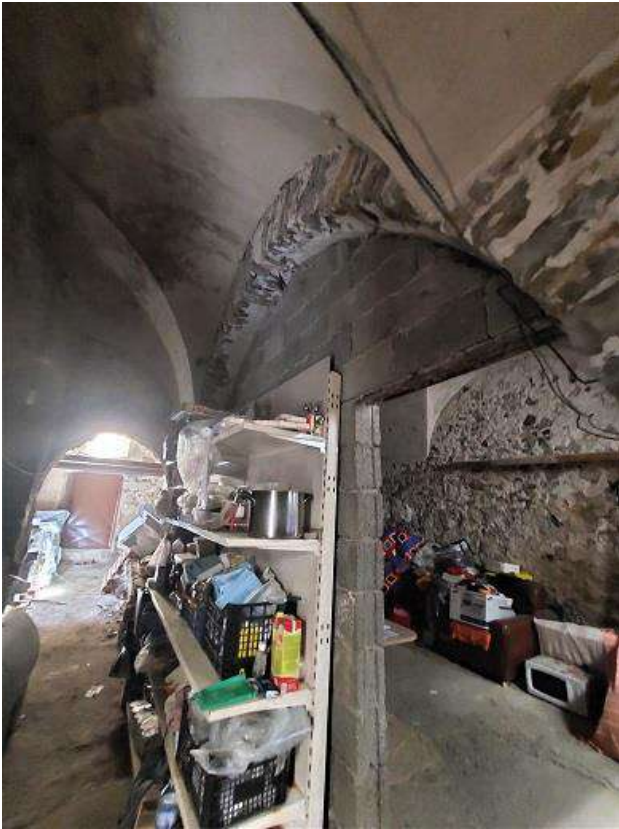
6 = Magazzino di P.T. – vano A (vista vano E)
