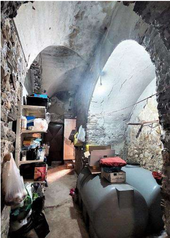
8 = Magazzino di P.T. – vano B (vista verso vano A)
