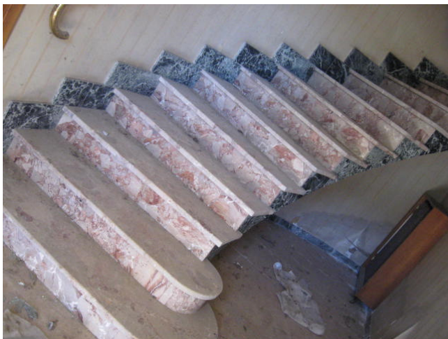
Scala interna e ingresso ascensore
