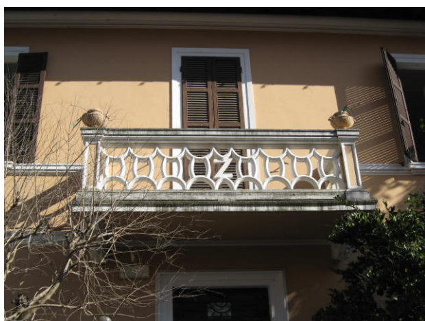
Balcone fronte strada e cancello di ingresso
