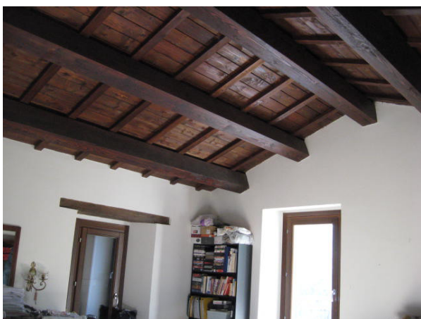
Camera e bagno piano primo
