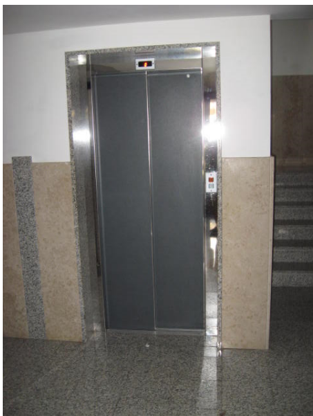
Vista ascensore e ingresso comune
