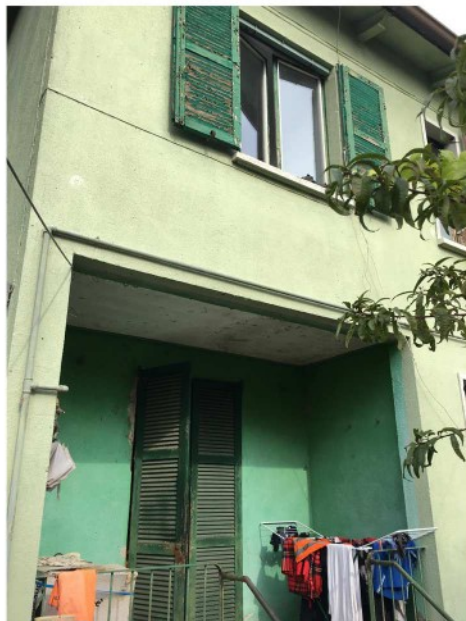
Foto 8: Vista esterna retro
