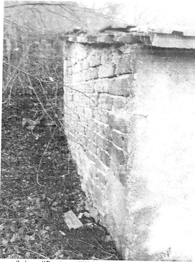
FOTO n. 22 – porcilaia edificata sull'IMMOBILE 2
