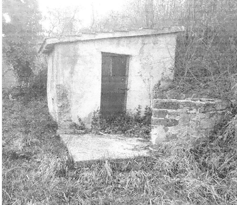
FOTO n. 20 – porcilaia edificata sull'IMMOBILE 2
