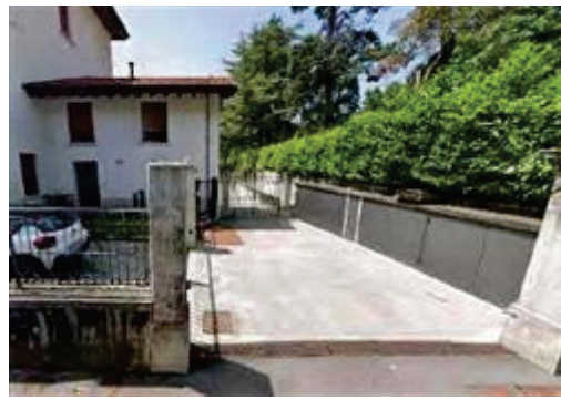
Vista ingresso autorimessa interrata da via Canzani
