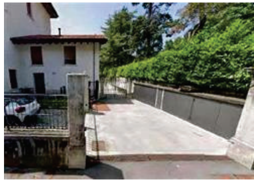
Vista ingresso autorimessa interrata da via Canzani
