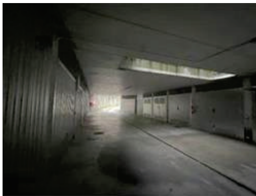
Vista corsello autorimesse
