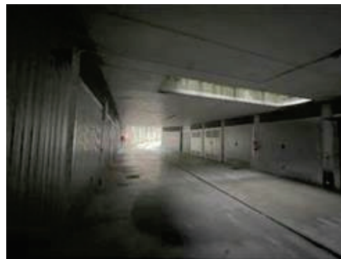
Vista corsello autorimesse
