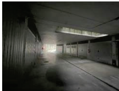
Vista corsello autorimesse
