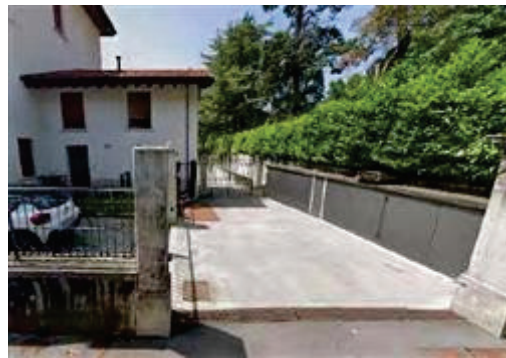
Vista ingresso autorimessa interrata da via Canzani
