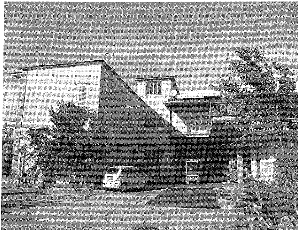
Vista interna della corte e prospetto sud del fabbricato
