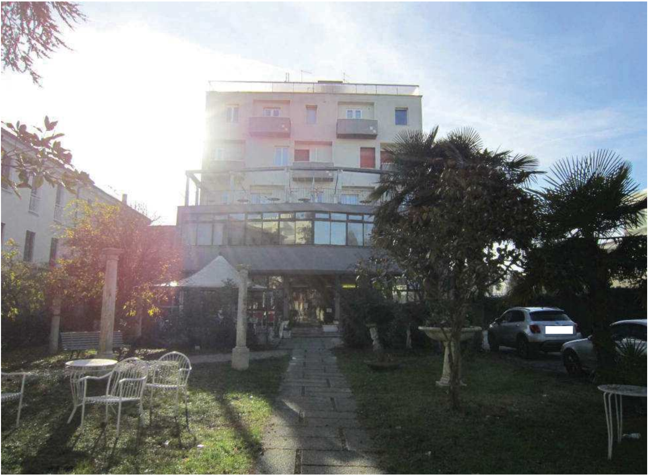
Veduta dell'ingresso pedonale verso l'hotel
