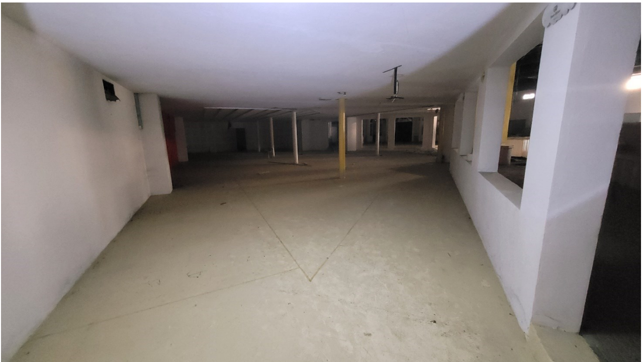
Locale al piano quota cortile
