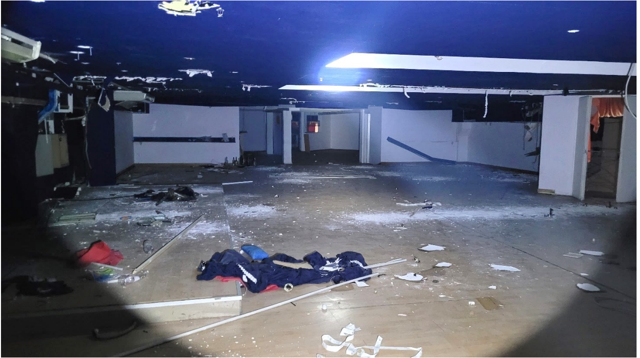
Locale al piano ammezzato
