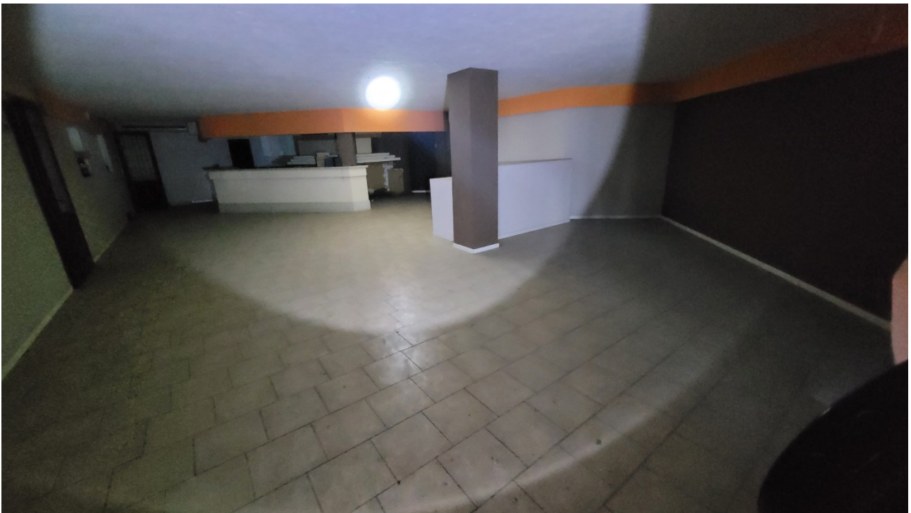
Locale al piano quota cortile
