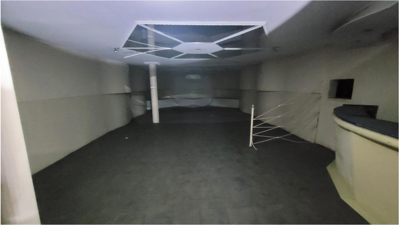
Locale al piano quota cortile
