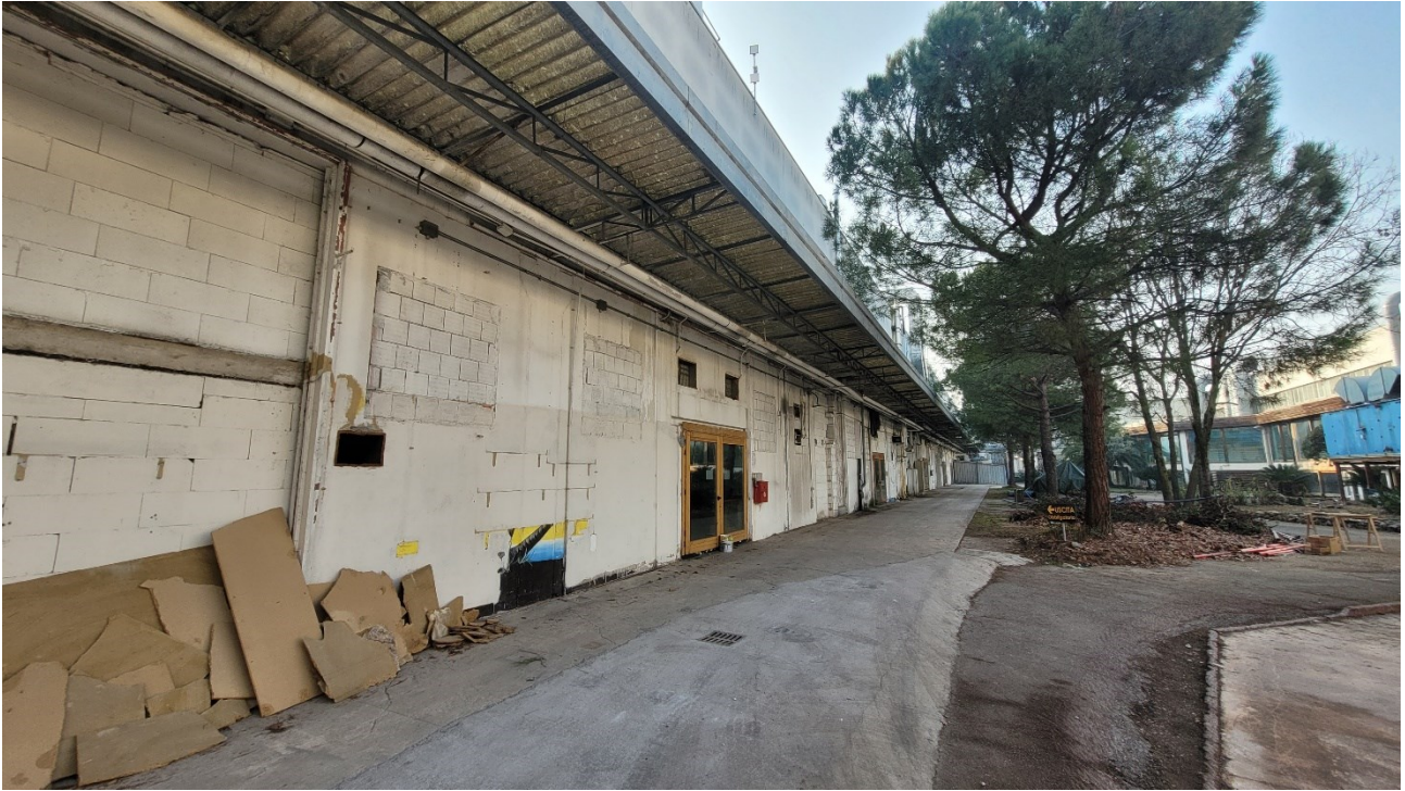
Vista del piano interrato dal cortile interno
