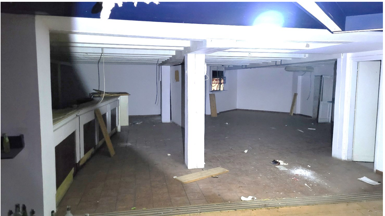
Locale al piano ammezzato
