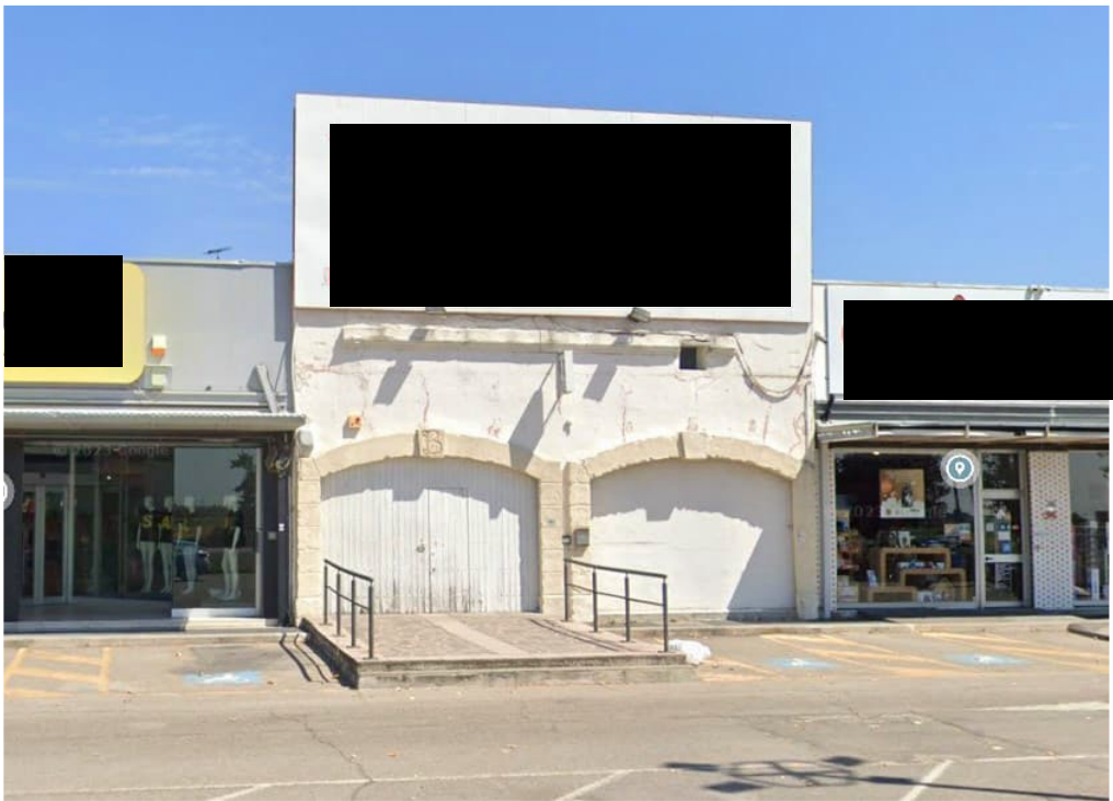
Ingresso al piano terra visto dal piazzale antistante
