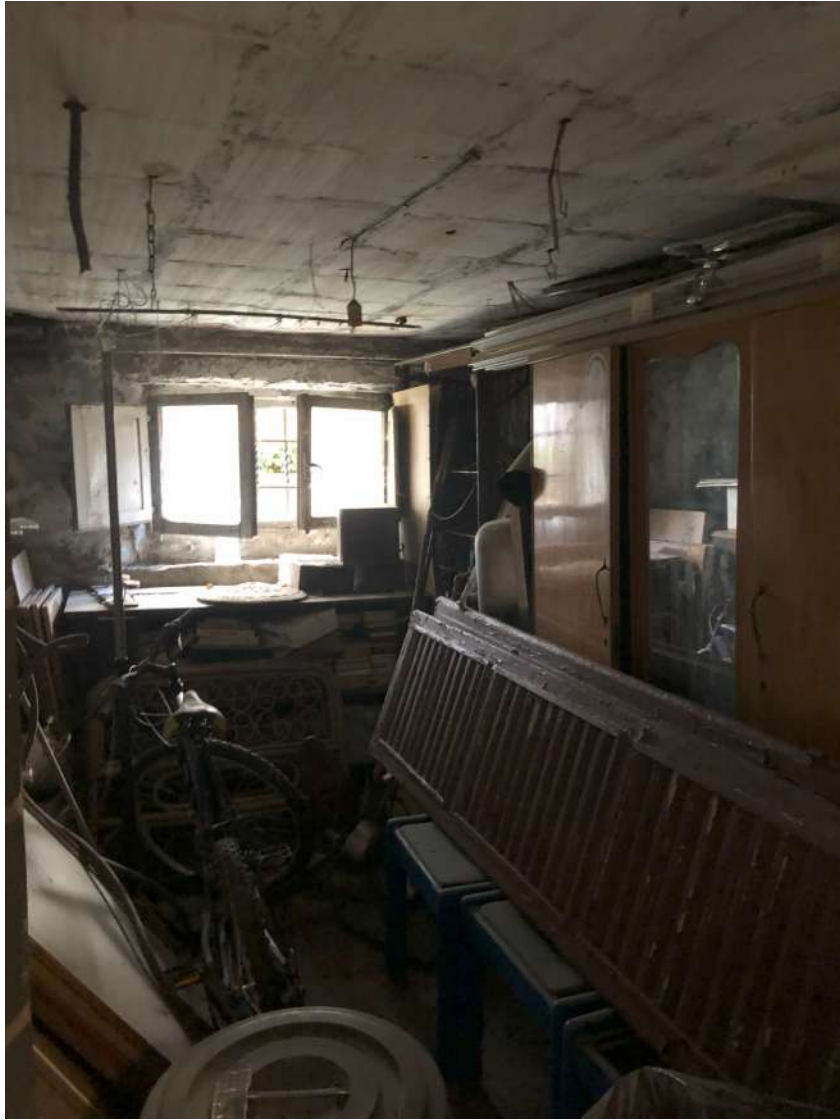
Foto 15- Sub.1 - seminterrato – 2° cantina
