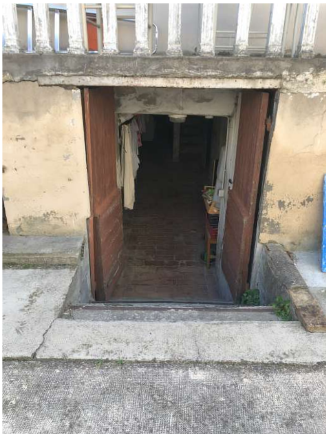
Foto 5- Accesso esterno al piano seminterrato
