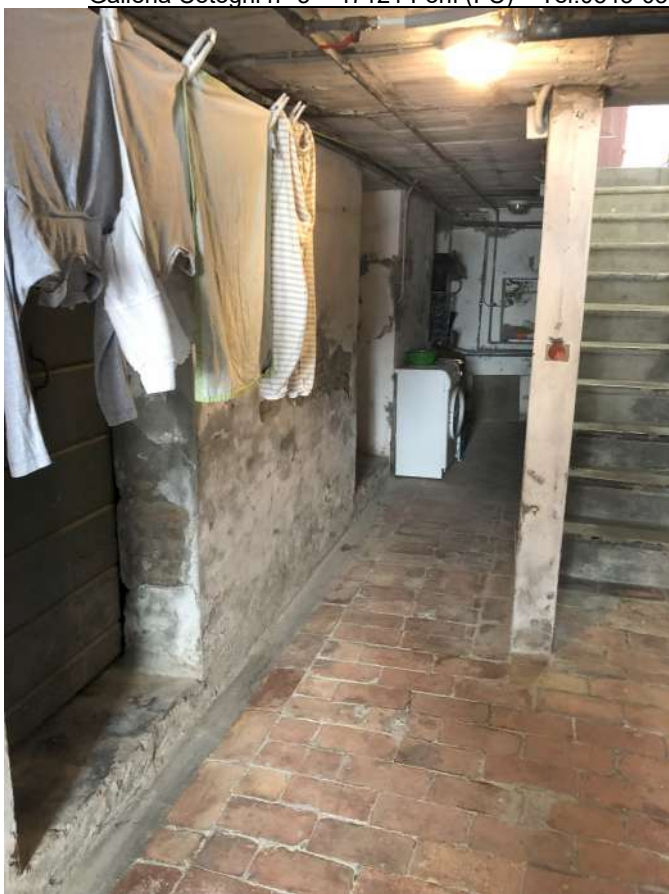
Foto 13- Piano seminterrato – area comune
