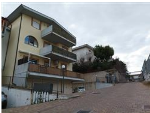
Fronte e accesso principale nella zona di monte del Condominio "Residence Les Maisons - corpo A"
