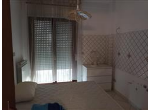
Cucina al piano terra erroneamente utilizzata come camera da letto
