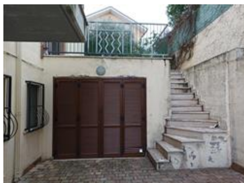
Pertinenza al piano interrato con accesso carrabile e relativa corte esclusiva di circa 45,00 mq
