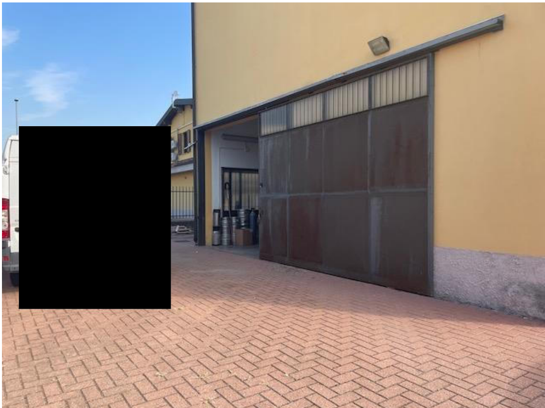
Cortile Area Esterna – Accesso al Magazzino
