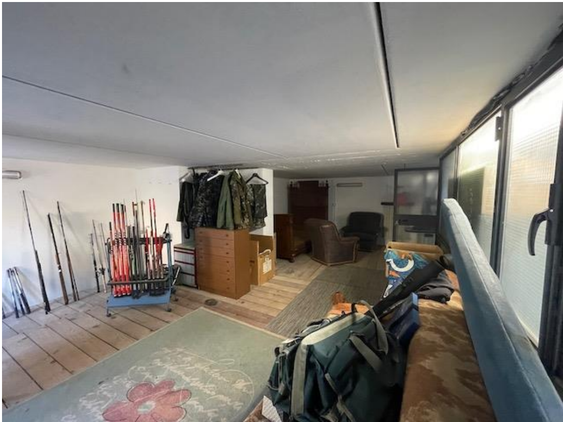
Zona Soprastante al magazzino ricavato da soppalco non autorizzato – altre viste
