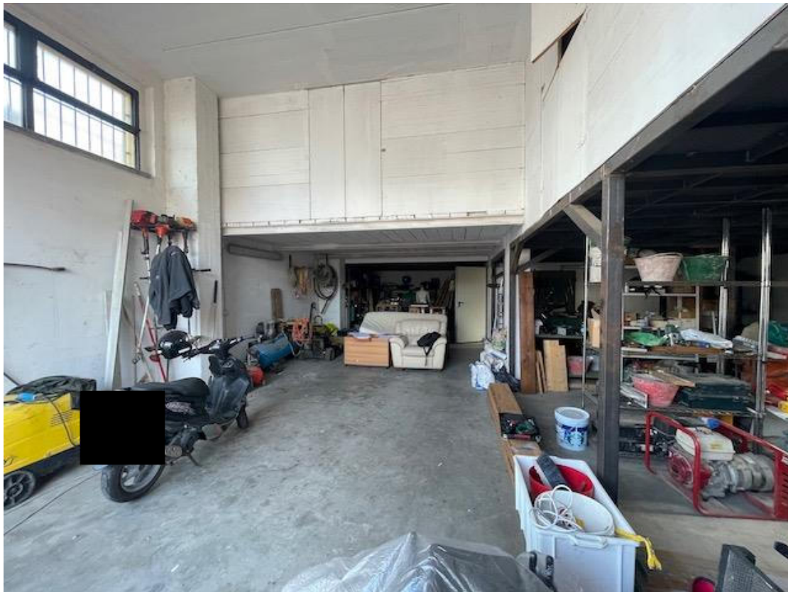
Vista Magazzino – sul fondo e sul retro presente soppalco non autorizzato
