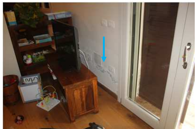
Foto 50 - 51: degrado da umidità alle pareti del soggiorno
