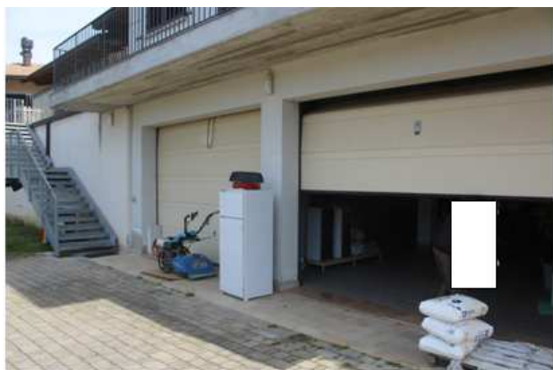
Foto 78: ingresso al deposito garage
