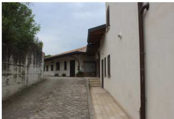
Foto 77: complesso – prospetto sud
