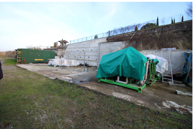
Foto 135: vista sull'area e macchinari ancora non rimossi
