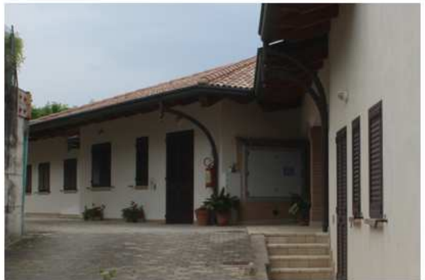
Foto 91: esterno – ingresso all'appartamento
