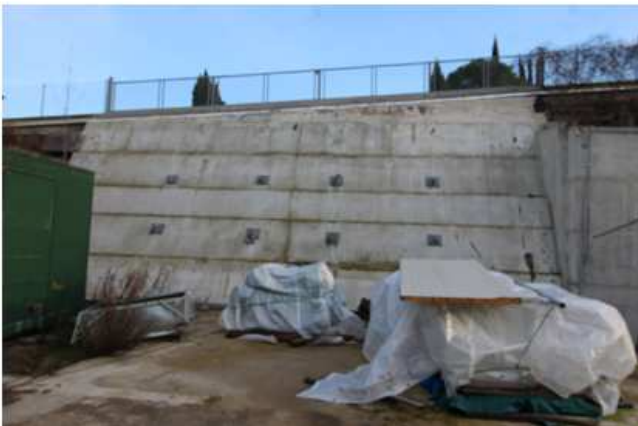
Foto 133-134: opere di sostegno e solette pavimentanti in cemento armato ancora presenti sul posto.
