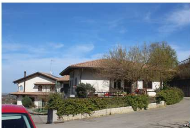
Foto 2: il complesso visto dal lato opposto all'ingresso
