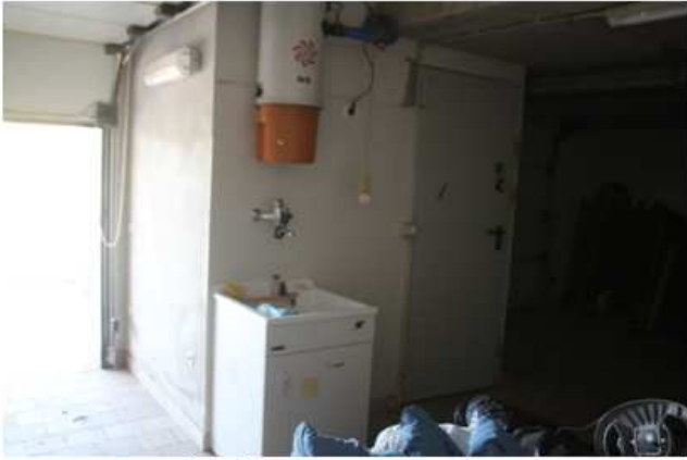
Foto 73: locale tecnico – esterno
