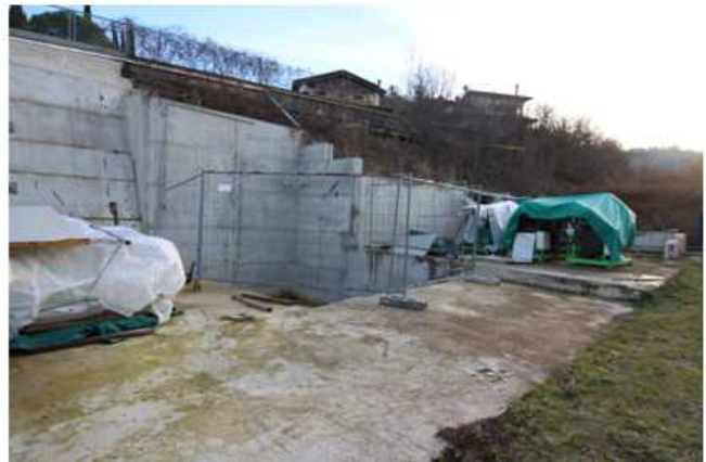
Foto 133-134: opere di sostegno e solette pavimentanti in cemento armato ancora presenti sul posto.
