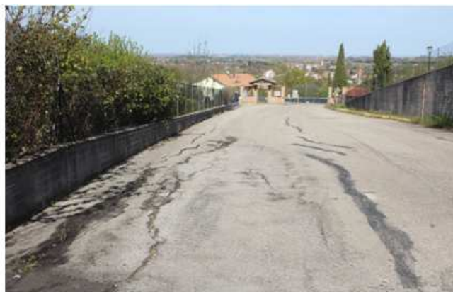
Foto 12-13: lesioni sulla carreggiata subparallele alle linee di equivello del versante
