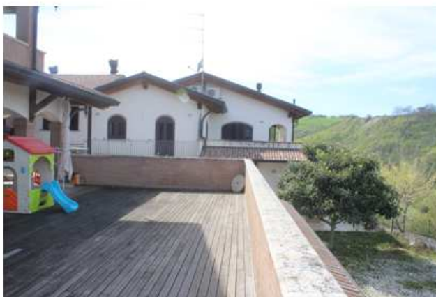
Foto 3: vista sui fabbricati in sequenza
