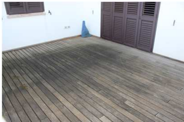
Foto 73 - 74: loggia e terrazzo
