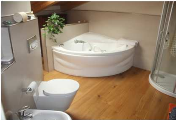
Foto 46: bagno con idromassaggio abusivo
