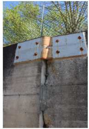
Foto 14-15-16: muro di sostegno sud e dettagli assestamenti e consolidamenti
