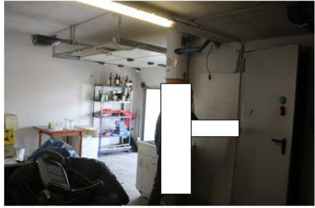
Foto 72: garage stallo lato ovest
