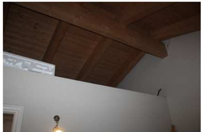
Foto 66: soppalco su guardaroba e copertura
