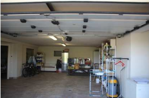
Foto 17: interno del garage
