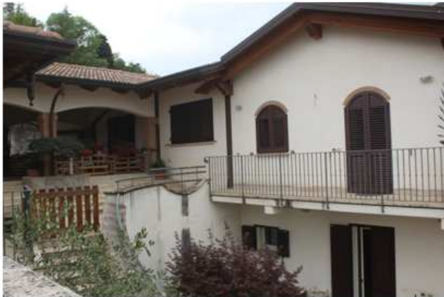
Foto 56: prospetto nord del fabbricato di cui al lotto 2
