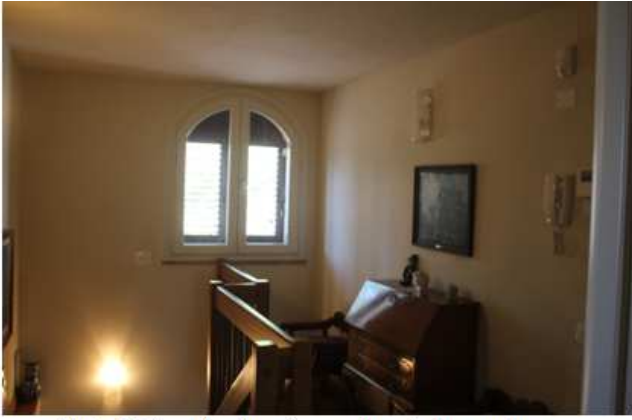
Foto 36: locale di arrivo scala al piano primo
