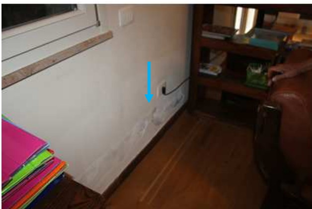
Foto 50 - 51: degrado da umidità alle pareti del soggiorno
