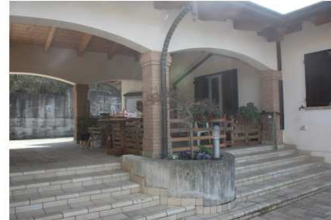
Foto 29: portico laterale al piano terra
