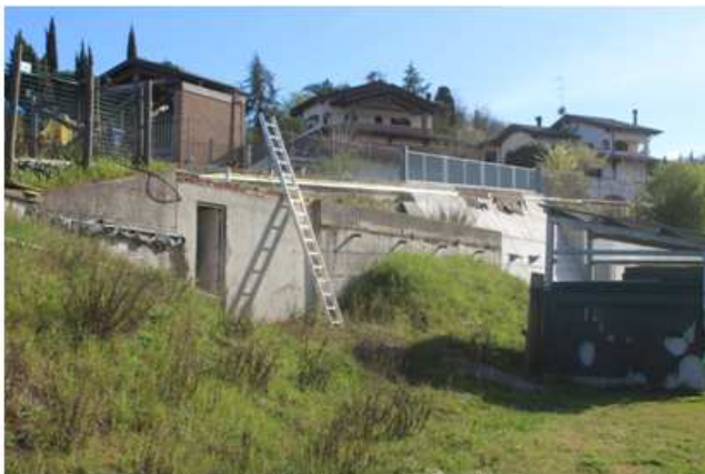
Foto 121: vista sul manufatto tecnico
