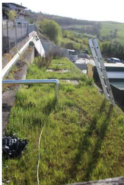
Foto 123: serbatoi idrici – vista da sopra
