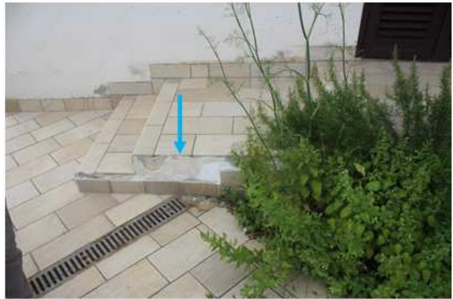
Foto 54 - 55: distacchi nelle pavimentazioni esterne prossime all'edificio
