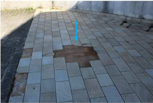
Foto 54 - 55: distacchi nelle pavimentazioni esterne prossime all'edificio
