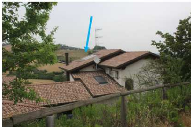
Foto 83: pannelli solari termici sopra abitazione lotto1
