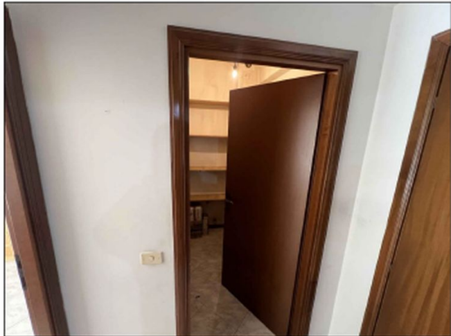
FOTO 9 - Rip. (già WC)
