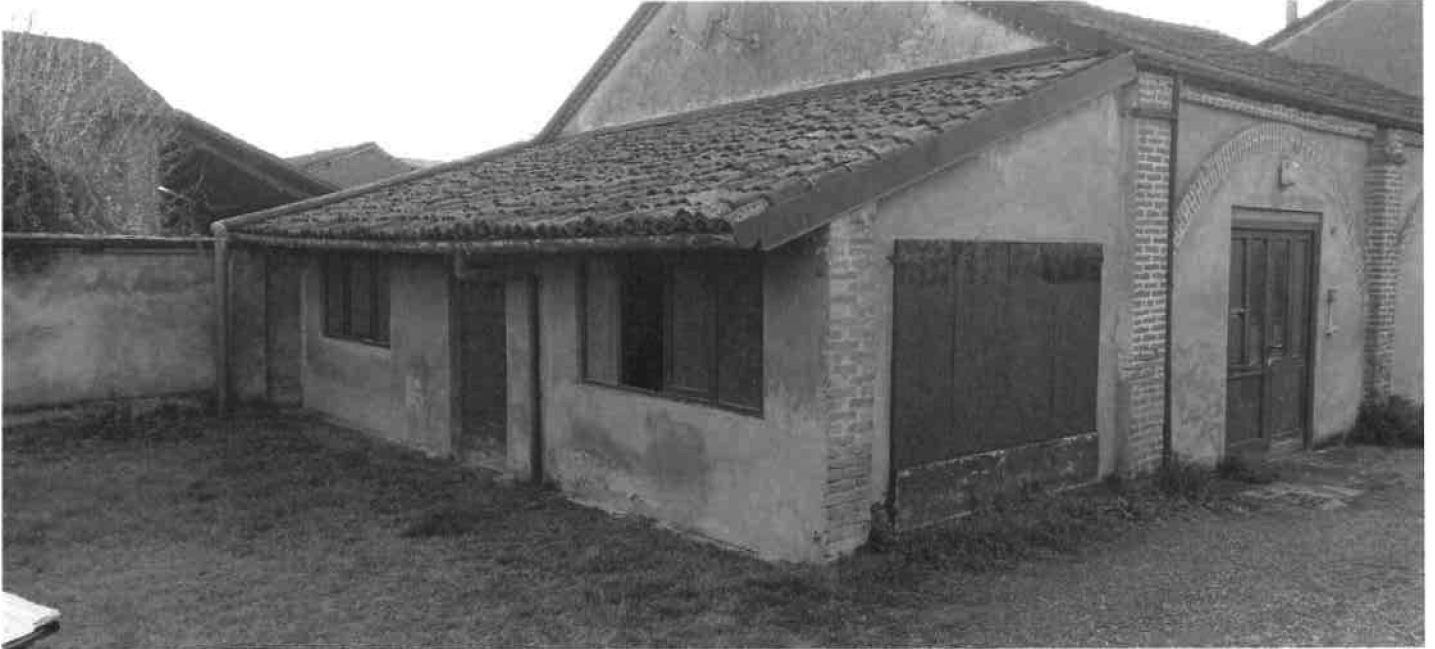
VISTA FACCIATA PRINCIPALE DA CORTILE COMUNE SUB 21
