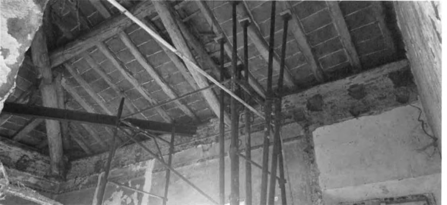
SUB 18 STRUTTURA TETTO SALA CON RIMOZIONE SOLAIO
