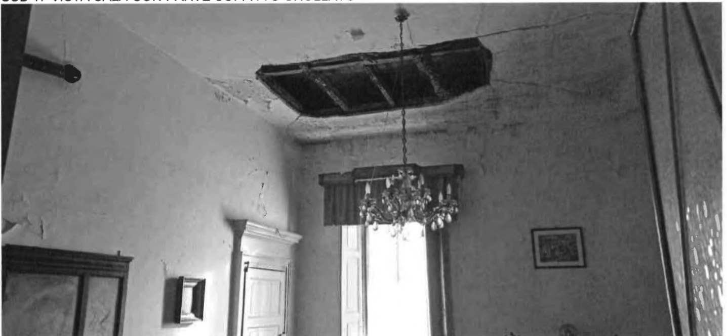
SUB 17 VISTA SALA CON PARTE SOFFITTO CROLLATO
