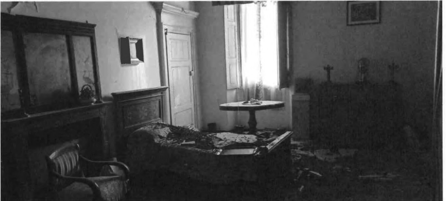
SUB 17 VISTA SALA CON PARTE SOFFITTO CROLLATO
