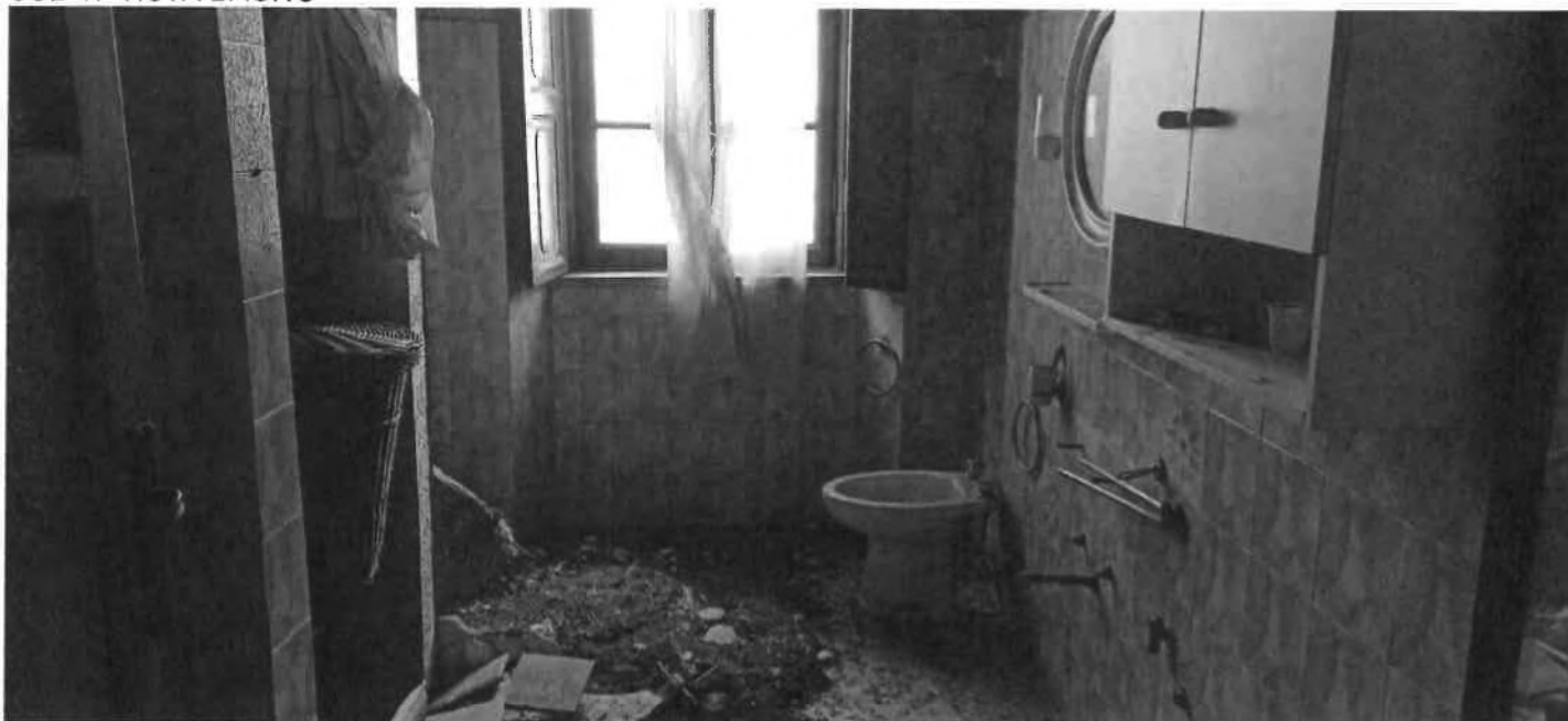
SUB 17 VISTA BAGNO
