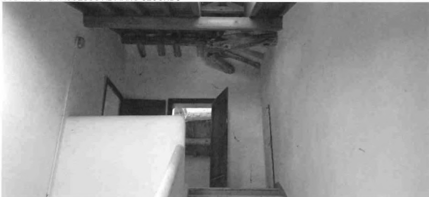
SUB 17 RIP - SOTTOTETTO
