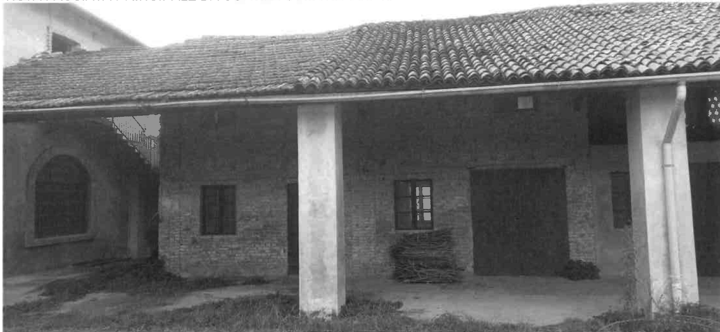
VISTA FACCIATA PRINCIPALE DA PORTICO COMUNE SUB. 21
