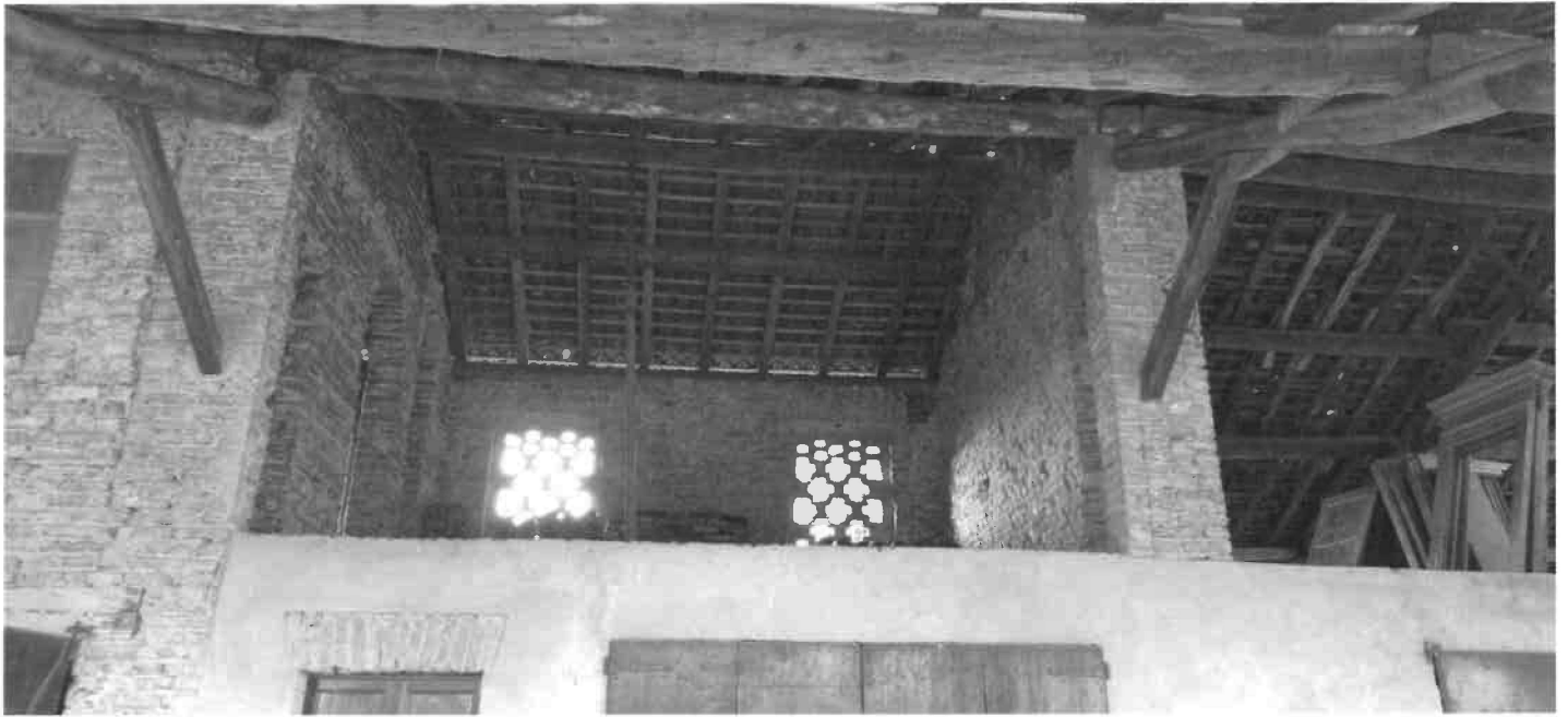
LOCALE CASCINA PIANO PRIMO
