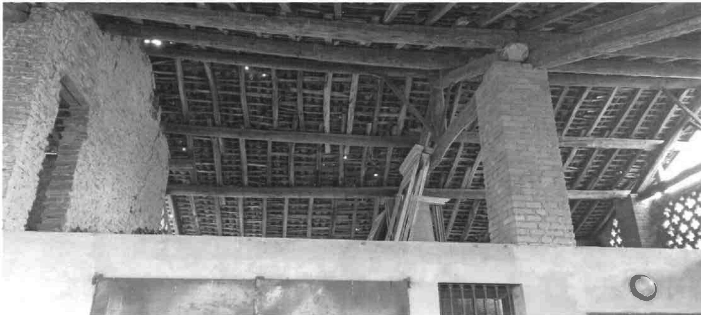
LOCALE CASCINA PIANO PRIMO
