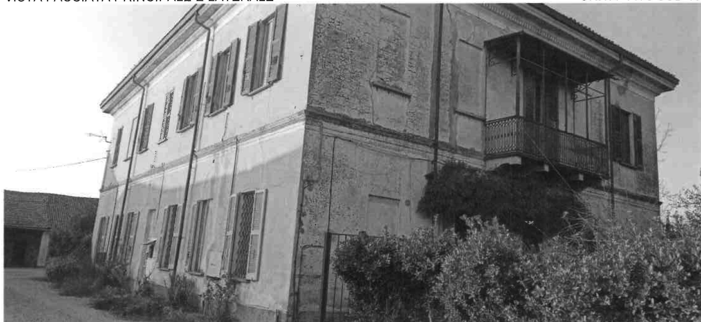
VISTA FACCIATA PRINCIPALE
