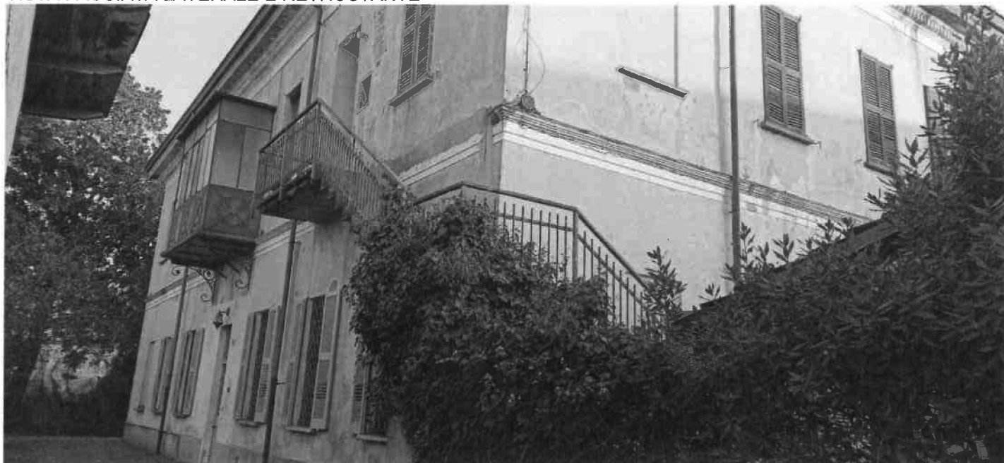
VISTA GIARDINO CASA PADRONALE
