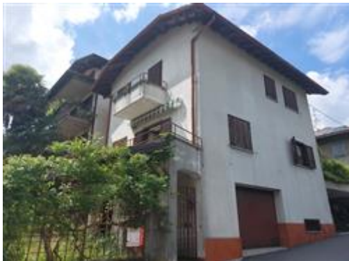
vista sud-est ingresso da via Peri fabbricato mapp. 118 subb. 2-3
