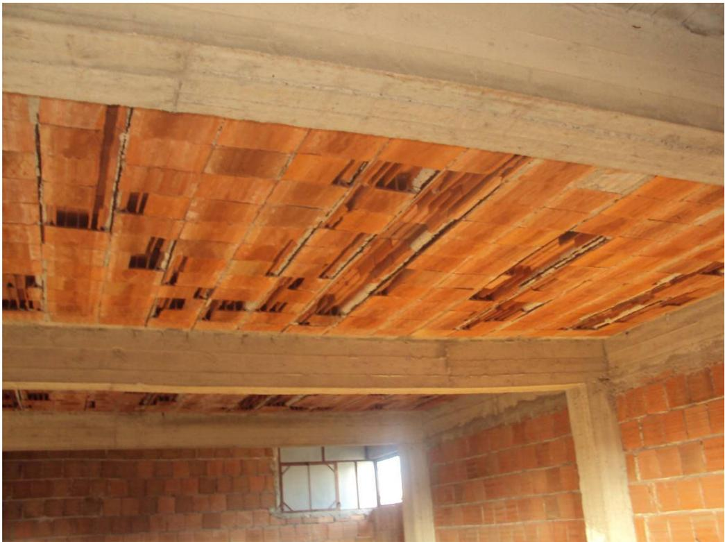
*Parte residua allo stato rustico con solai crollati e infiltrazioni provenienti dal soprastante lastrico solare*
